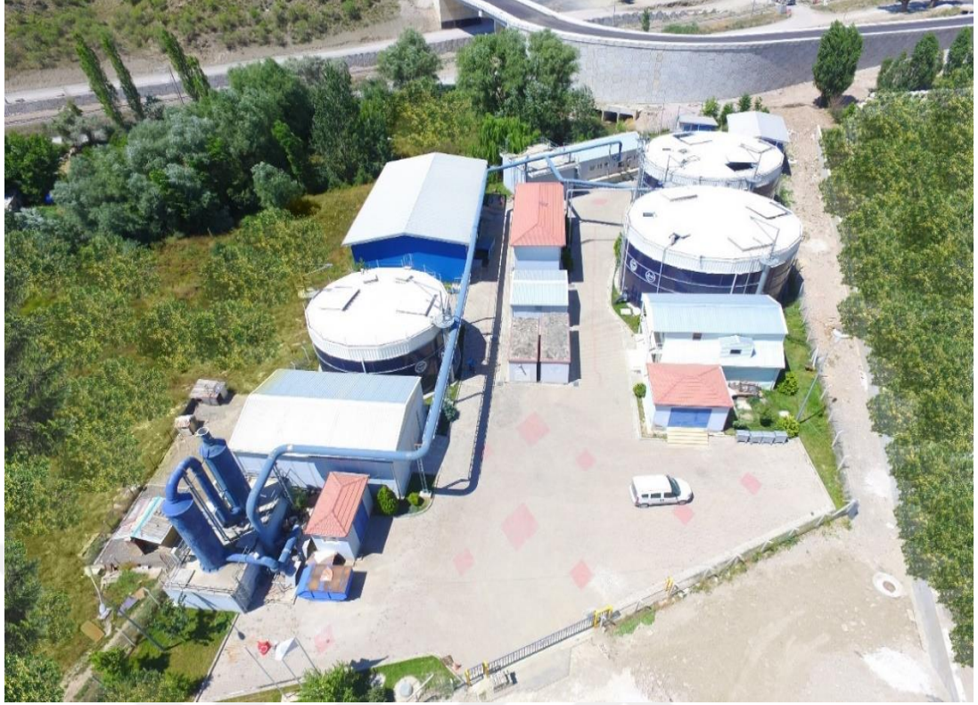
Şekil 4.3. Lalahan atıksu arıtma tesisi
