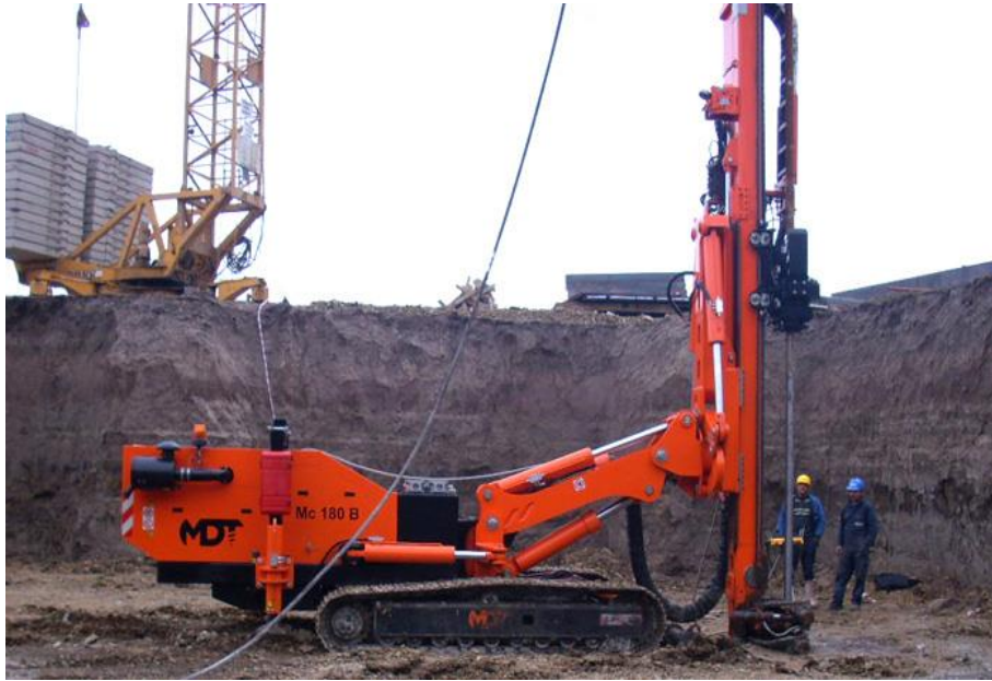
Şekil 3.5. Jet grout delgi makinesi
