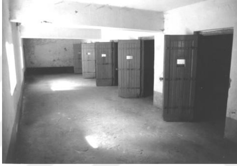
Şekil 2. 43 Sinop Hapishanesi'nin restorasyon geçirmiş binasındaki hücre/koğuş galerisi
