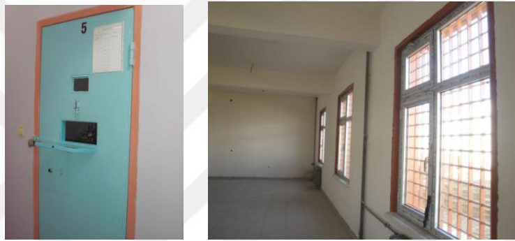
Şekil 5.2 Mahpus oda kapısı ve doğal aydınlatma havalandırma amaçlı pencereler
