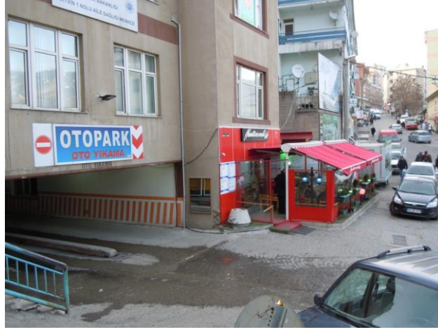
Şekil 5. 80 İl Özel İdaresi Otopark alanının giriş bölümünden görünüş
