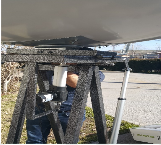
Şekil 5. SMGTS montaj çalışmaları
