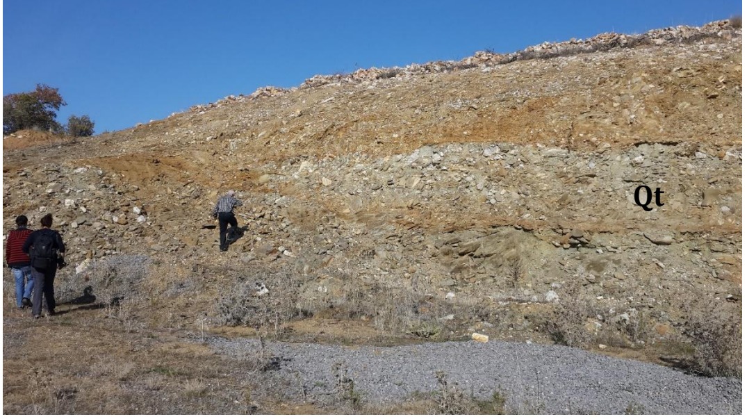
Şekil 4.31. Gökhasanlı mahallesi Eroğlu köyü arasındaki yol yarması.
