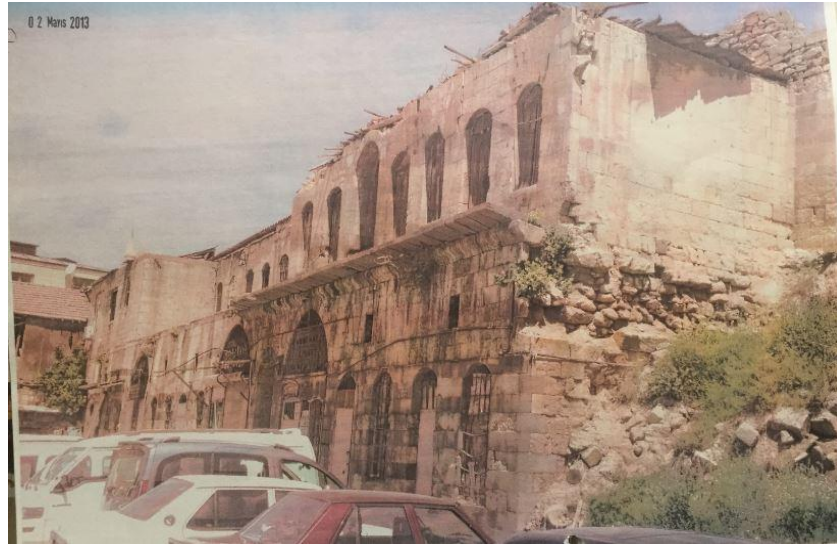
Şekil 6.28: Emir Ali Hanı Kuzey Cephe (Gaziantep Kültür Varlıklarını Koruma Bölge Kurulu Müdürlüğü Arşivinden)
