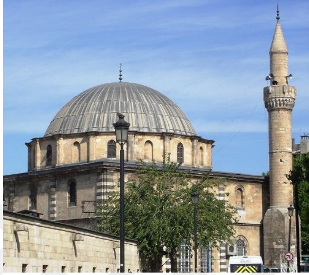
Şekil 6.42: Alaüddevle Camii Siyah ve Beyaz Kesme Taş Düzeni
