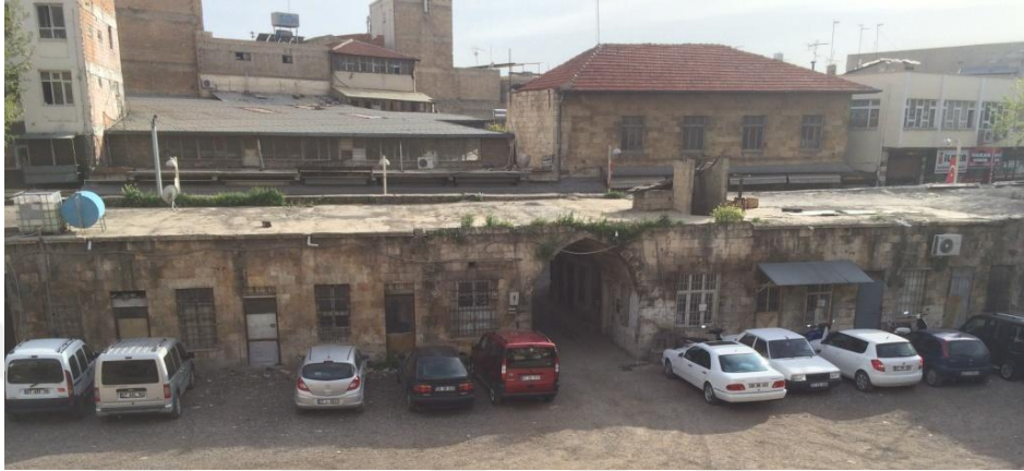
Şekil 6.35: Emir Ali Hanı Güney Cephe
