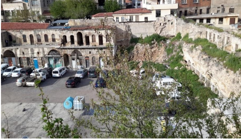
Şekil 6.3: Emir Ali Han Kuzey ve Doğu Cephelerden Görünüş
