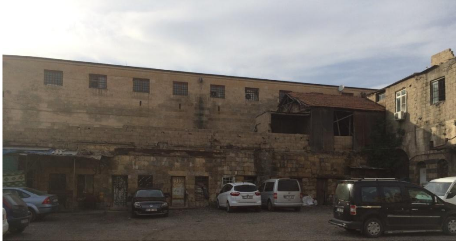
Şekil 6.22: Emir Ali Hanı Batı Cephe
