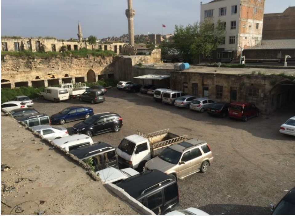
Şekil 6.19: Emir Ali Hanı Avludan Görünüm
