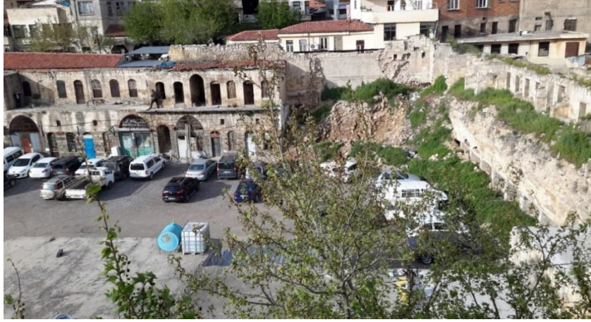
Şekil 6.16: Emir Ali Hanı Doğu Cephe Görünüş
