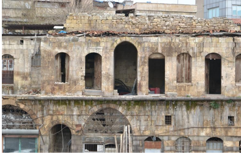
Şekil 6.5: Emir Ali Han Kuzey Cepheden İkinci Kat Görünüş
