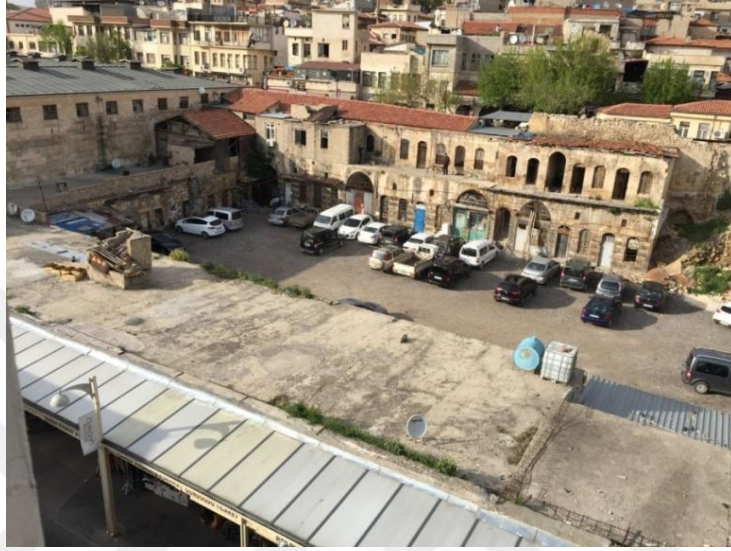
Şekil 6.27: Emir Ali Hanı Kuzey, Güney ve Batı Cephelerden Görünüş
