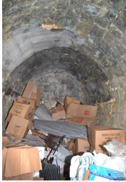
Şekil 6.24: Emir Ali Hanı Batı Cephe İç Mekân Detay
