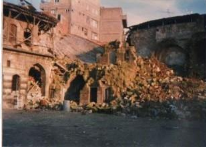
Şekil 6.18: Emir Ali Hanı Doğu Cephe Yıkılan Mekânlar Görünüşü (Gaziantep Kültür Varlıklarını Koruma Bölge Kurulu Müdürlüğü Arşivinden)
