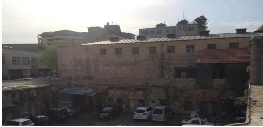
Şekil 6.20: Emir Ali Hanı Batı Cephe
