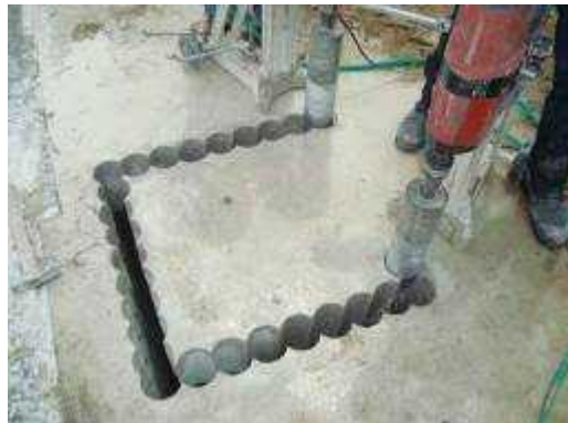
Şekil 4.9. Döşemeden karot alımı ( www.karotmanavgat.com )
