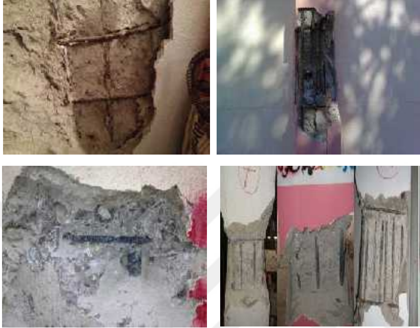
Şekil 4.14. Sıyırma örnekleri (bu çalışmadan ve Uyanık 2014’den düzenlenmiştir)
