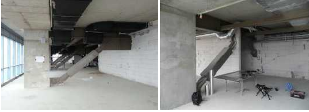
Şekil 6.34 Deprem sönümlleme mekanizması
