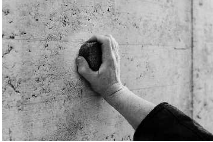
4.2. Yüzeyi pürüzsüz hale getirme işlemi
