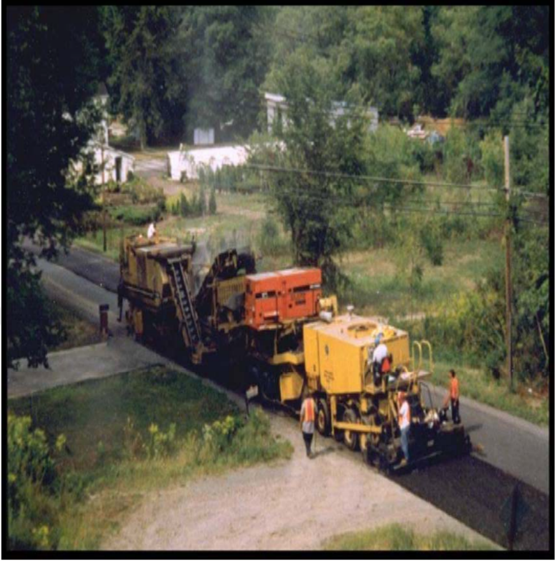
Şekil 3.6. Soğuk yerinde geri dönüşüm katarı ( Aksoy, 1993)
