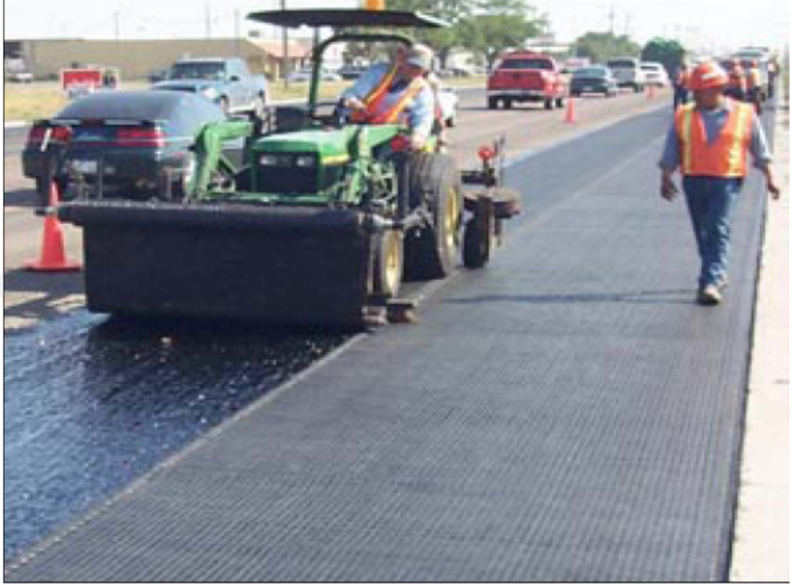
Şekil 1.5. Geosentetik rulo serilme (Aksoy, 1993)
