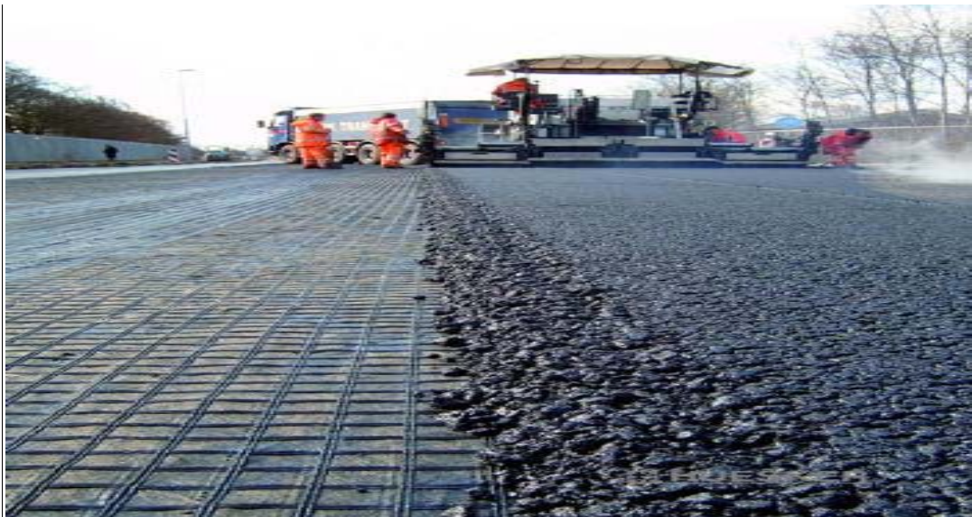
Şekil 1.6. Asfalt Kaplaması serilme (Joe ve Button, 2003)
