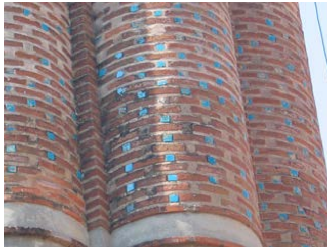
Şekil 3.8. Yivli Minare çini malzeme kullanımı.
