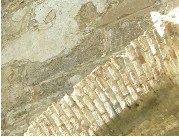
Şekil 3.29. Yapıda tuğla kullanımı.
