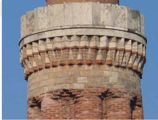
Şekil 3.7. Yivli Minare şerefe ve şerefe korkuluğunda kullanılan taş kaplamalar.
