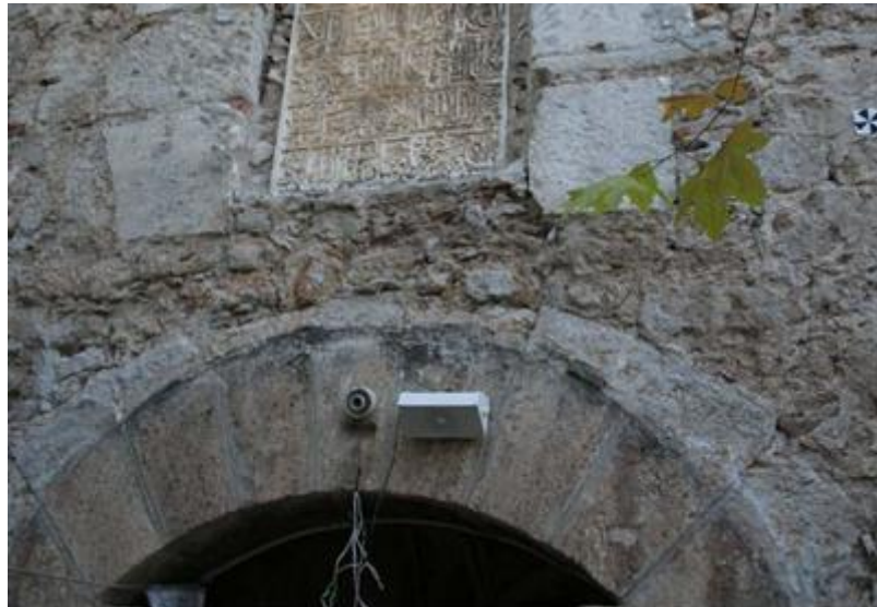
Şekil 3.5. Yivli Minare Camii bölümünde taş malzeme kullanımı.
