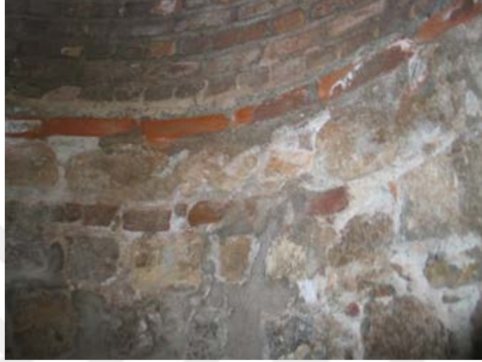
Şekil 3.17. Yivli Minare iç bölümlerindeki nem ve tuz çıkışları.
