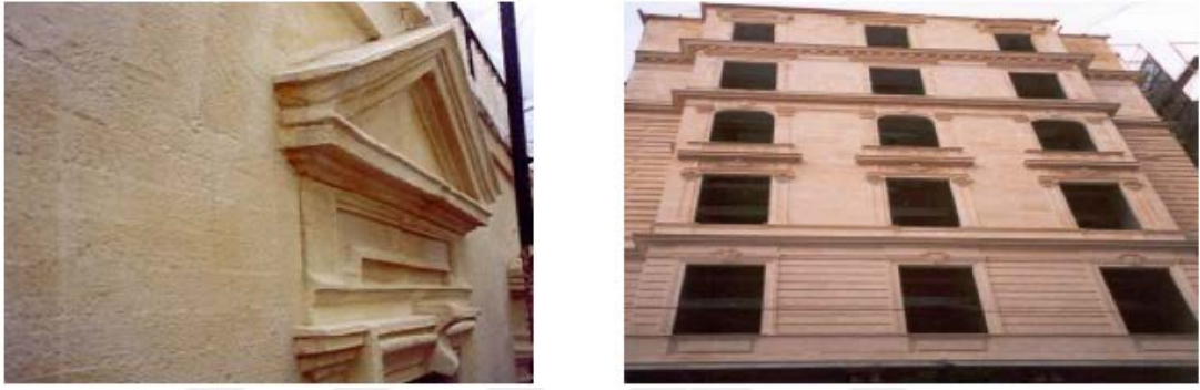
Şekil 2.32. Cephe temizliği yapılmış binalar.
