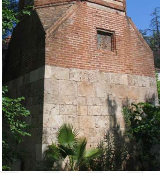
Şekil 3.6. Yivli Minare kaidesinde kesme taş malzeme kullanımı.
