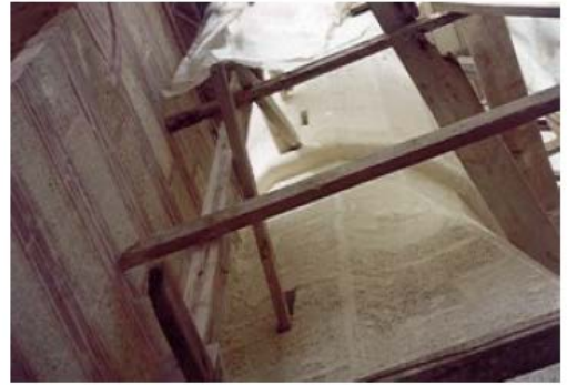
Şekil 2.30. İşlenmiş taşların istiflenmesi ve montajı.
