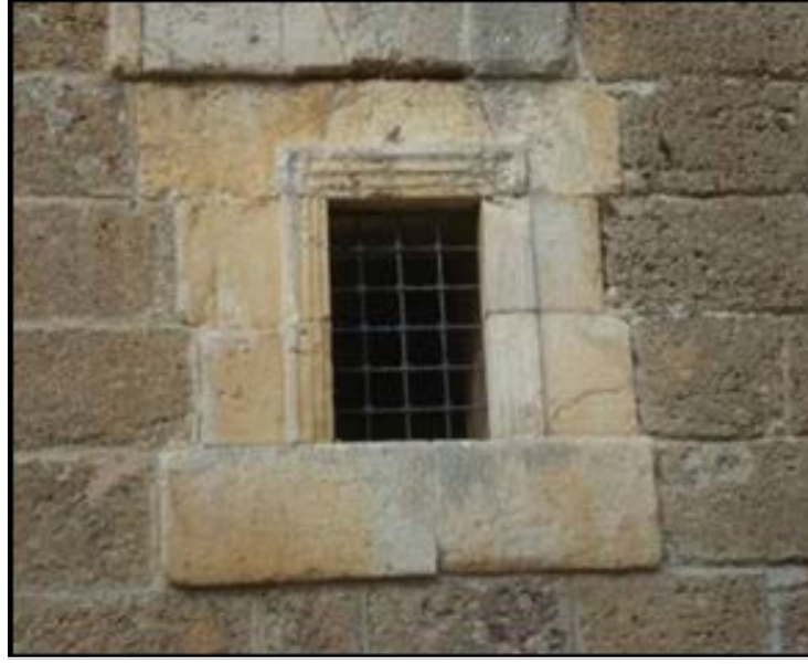
Şekil 3.27. Yapıda kireçtaşı bloklarının kullanımı.
