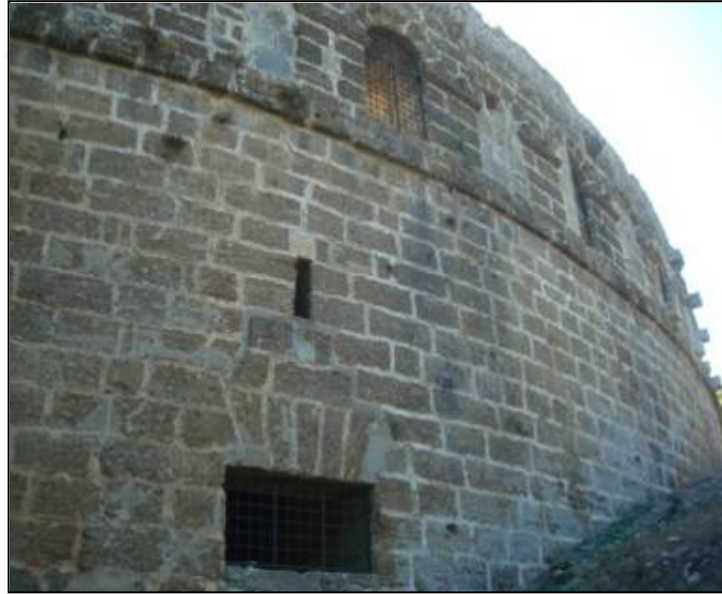
Şekil 3.26. Yapıda konglomera taş bloklarının kullanımı.
