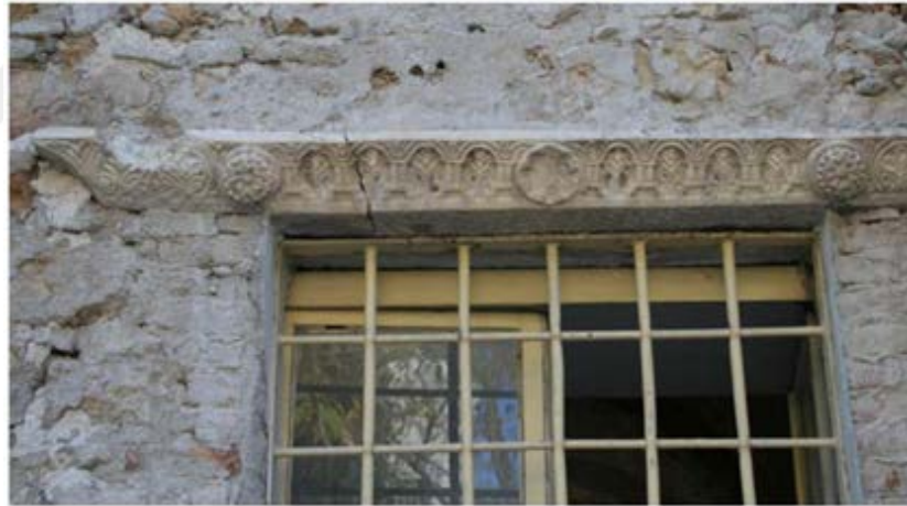
Şekil 3.9. Dış cephede pencere lentosu olarak kullanılan Bizans dönemi spolienleri.
