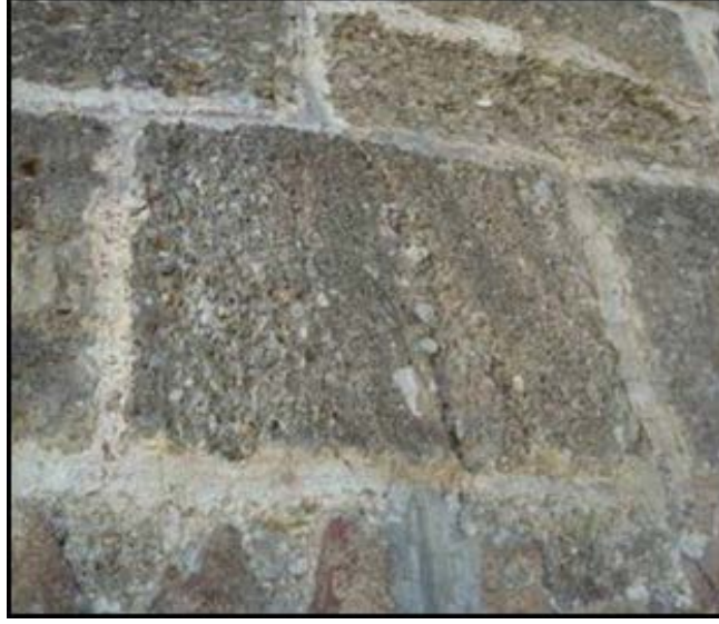
Şekil 3.28. Yapıda derz harcı kullanımı.
