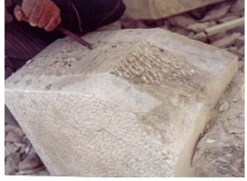
Şekil 2.29. Taş ocağından kütleler halinde getirilen taşların işlenmesi.
