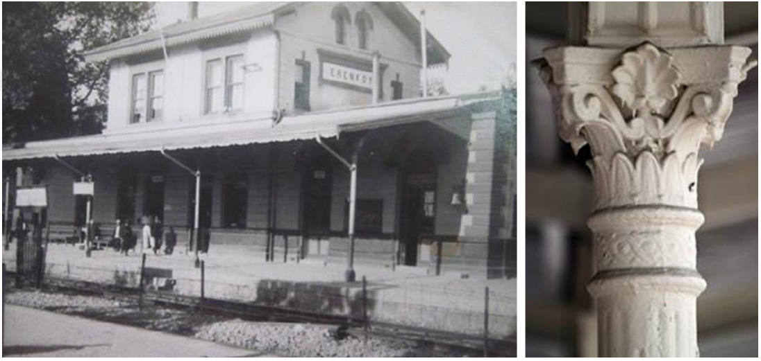
Şekil 60 - Erenköy İstasyonu fotoğrafı (1935-1945) ve dökme demir istasyon kanopisinin detayı (URL-27; İstanbul V Numaralı KVKBK arşivi)
