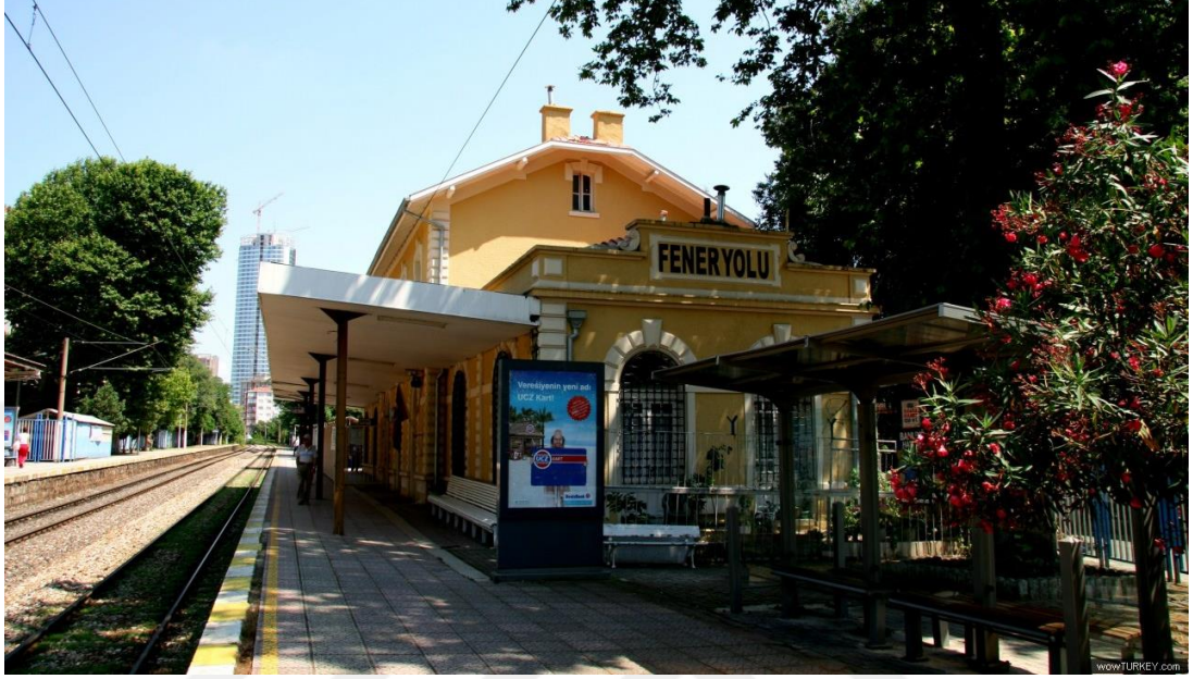
Şekil 24 - Feneryolu yolcu binası (URL-11)
