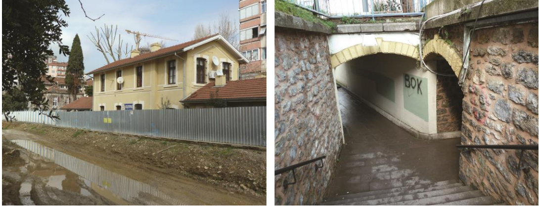
Şekil 50 - Kızıltoprak İstasyonu lojman yapısı ve yaya alt geçidi
