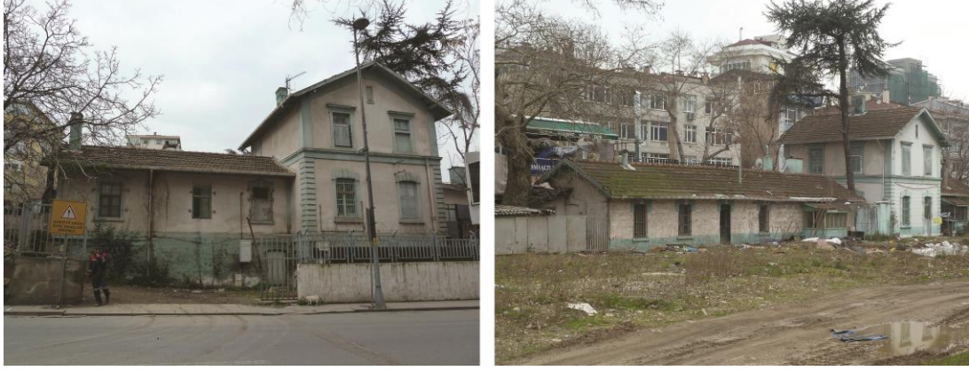
Şekil 70 - Bostancı İstasyonu lojman yapısı
