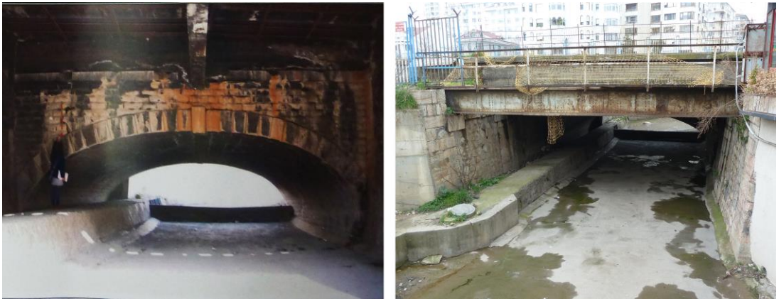
Şekil 77 - Bostancı nehir geçiş köprüsü (Soldaki fotoğraf (İstanbul V Numaralı KVKBK arşivinden alınmıştır.)
