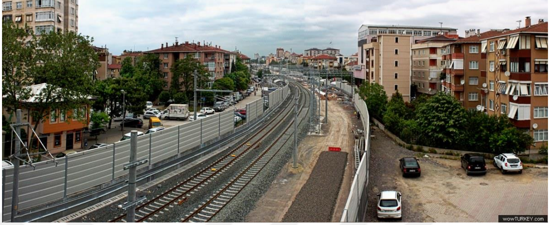
Şekil 45 - Pendik'te inşa edilen güvenlik duvarı ve ses bariyeri (URL-24)
