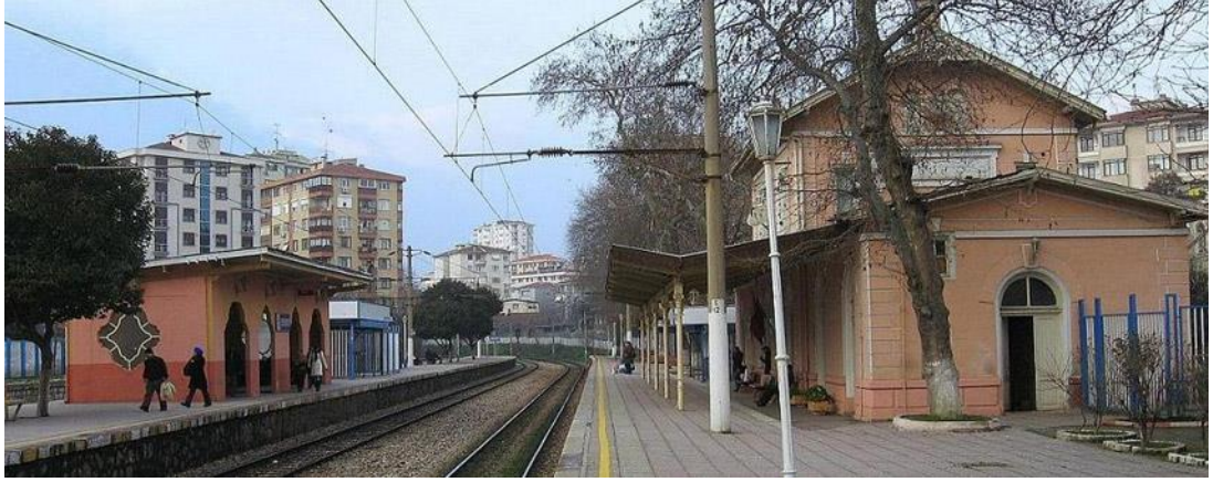
Şekil 61 - Erenköy İstasyon binası ve yolcu bekleme bölümü (URL-28)
