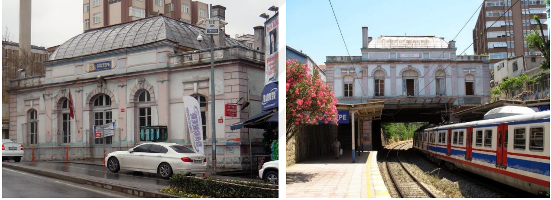
Şekil 26 - Göztepe yolcu binası (URL-12)
