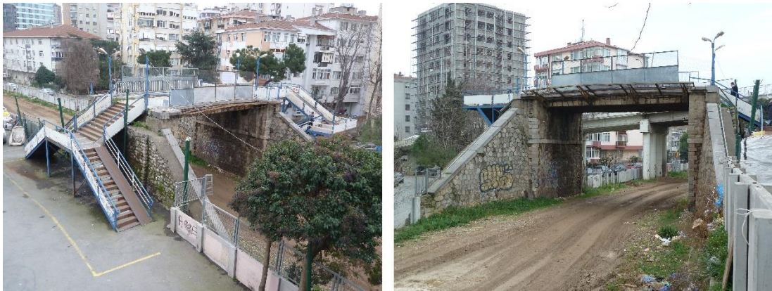
Şekil 75 – Göztepe Selamiçeşme Köprüsü
