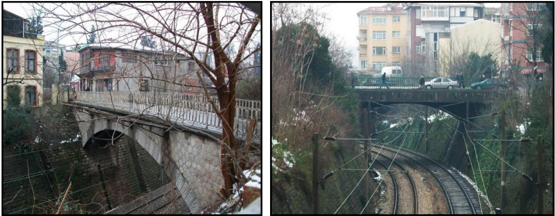
Şekil 73 - Hasanpaşa ve Hasanpaşa Yıldızbakkal Köprüleri (TMMOB Mimarlar Odası İstanbul Büyükkent Şubesi Arşivi)
