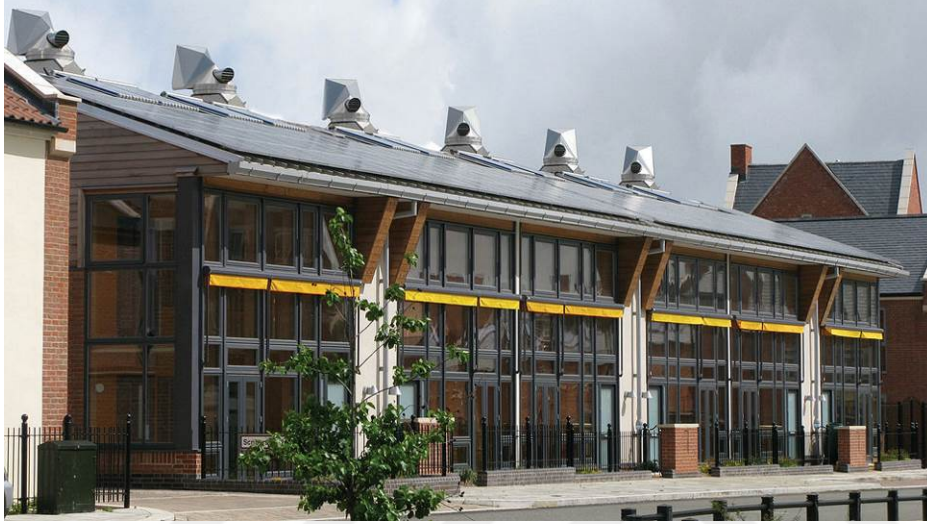
Şekil 2.16 : Upton Rural binasının dışarıdan görüntüsü (Url-11)
