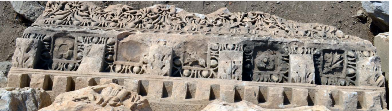
Figür 65: Korniş bloğu alttan genel görünüm.
