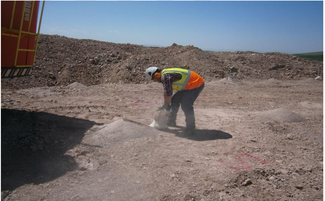
Şekil 3.18. Delik delme işleminde çıkan pasalardan örnek alım işlemi
