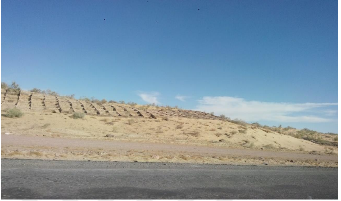
Şekil 21: Merkez Karakum'dan bir barkan sırası görünümü. Barkanların yola doğru hareket etmemesi için oluşturulmuş bir kalkan.
