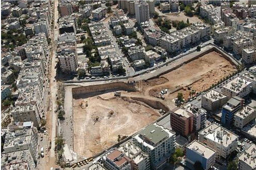
Figure 5 Present state of Antalya Doğu Garajı
