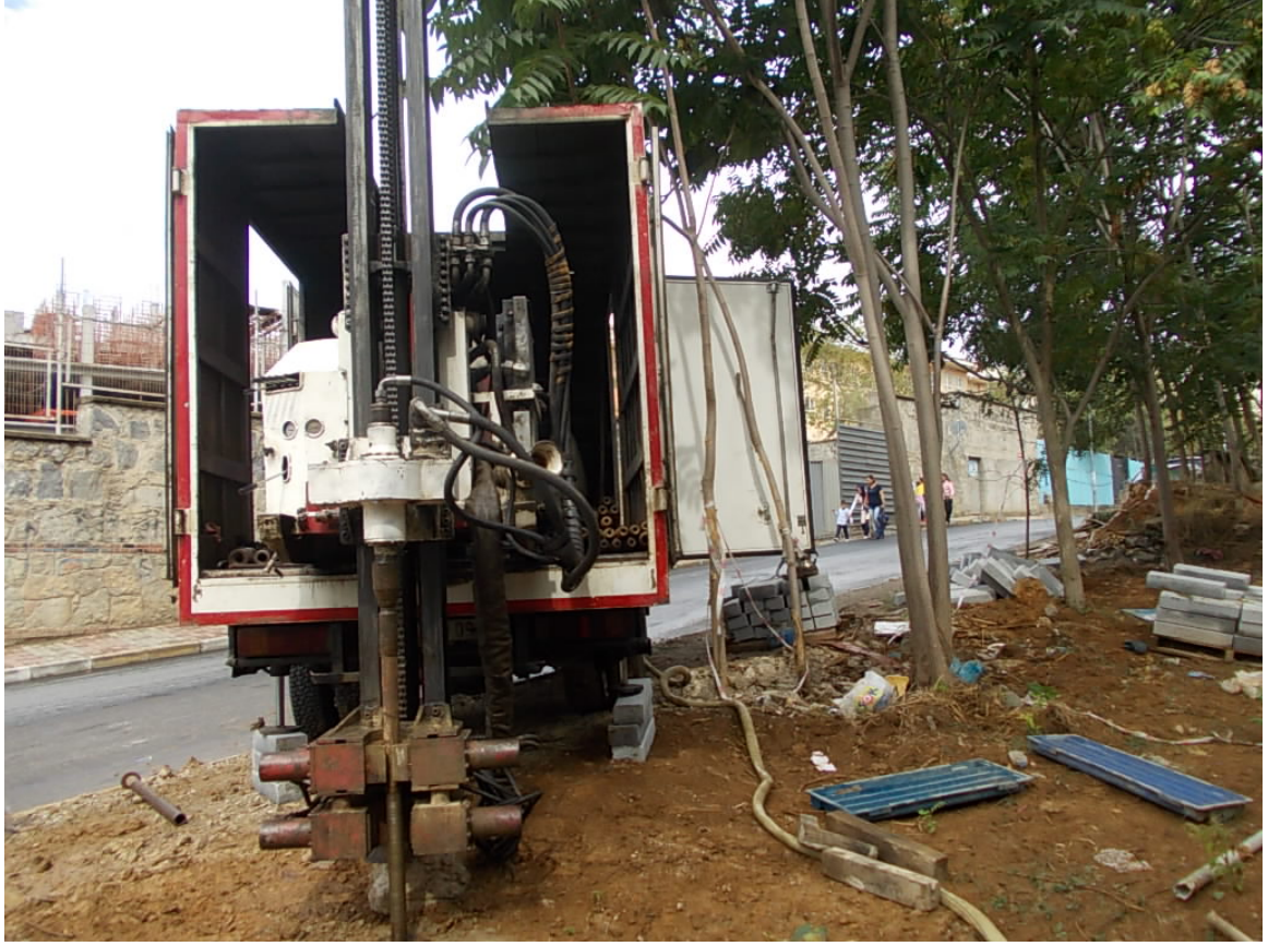
Şekil 4. 75 A17 Memba Alanındaki 12-Nolu Gözlem Kuyusu'na ait Sondaj Resimleri
