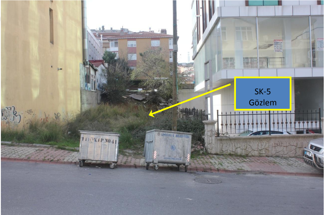
Şekil 4. 35 Memba Alanı-6 Üzerindeki SK-5'in Görünümü
