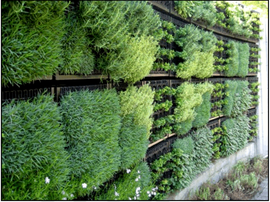
Şekil 3.2-4 Tıbbi bitkiler dikilen yeşil duvar sistemi
