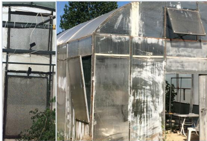
Şekil 3.22 Sera sistemindeki havalandırma pencereleri
