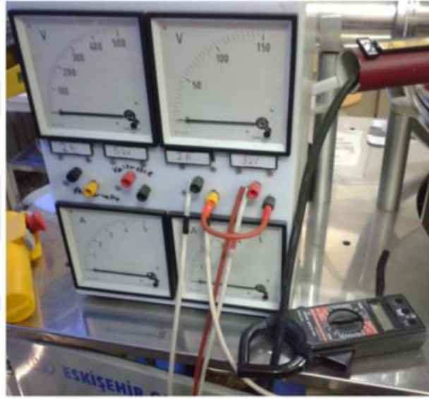
Şekil 4.10. Amperetreler ve voltmetreler sistemi
