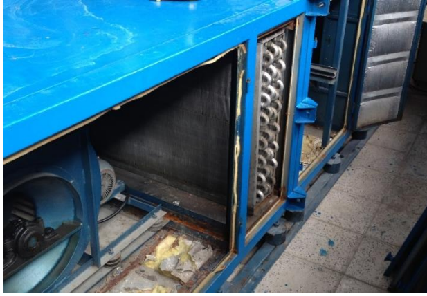
Şekil 3.7. Sistemde kullanılan evaporatörün resmi
