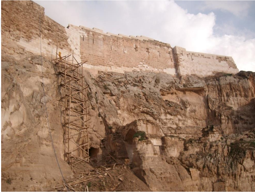
Şekil 4.59. Batı surları 2009 yılı restorasyon çalışmaları sırasındaki görünüşü (Gören Mimarlık, 2009)
