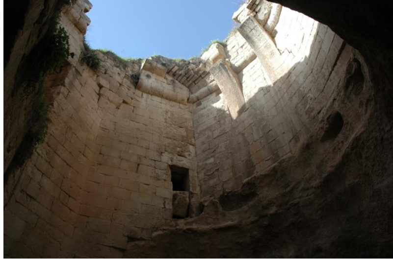
Şekil 4.40. Rumkale sarnıç duvarları (Anonim, 2012)
