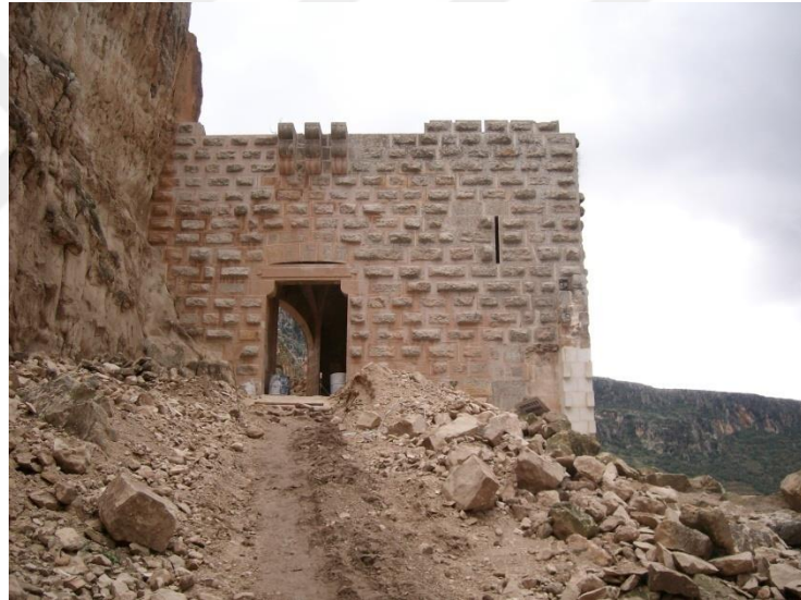
Şekil 4.49. B02 kapısı 2009 yılı restorasyon çalışmaları sırasındaki görünüşü (Gören Mimarlık, 2009)
