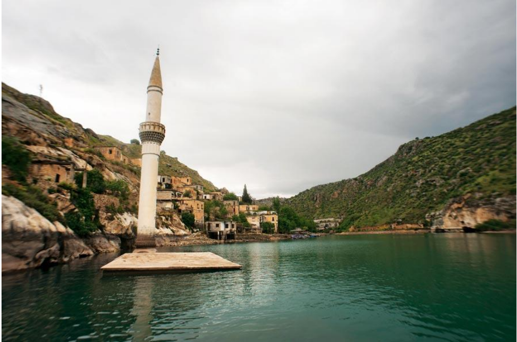
Şekil 4.16. Baraj sularından etkilenen Halfeti ilçesine bağlı Savaşan köyü (Atlas Dergisi, 2013)
