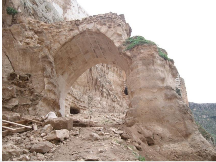
Şekil 4.47. B01 kapısı 2009 yılı restorasyon çalışmaları sırasındaki görünüşü (Gören Mimarlık, 2009)
