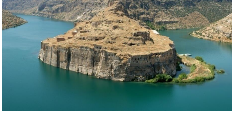
Şekil 4.26. Birecik Barajı sonrası Rumkale (Gören Mimarlık, 2012)
