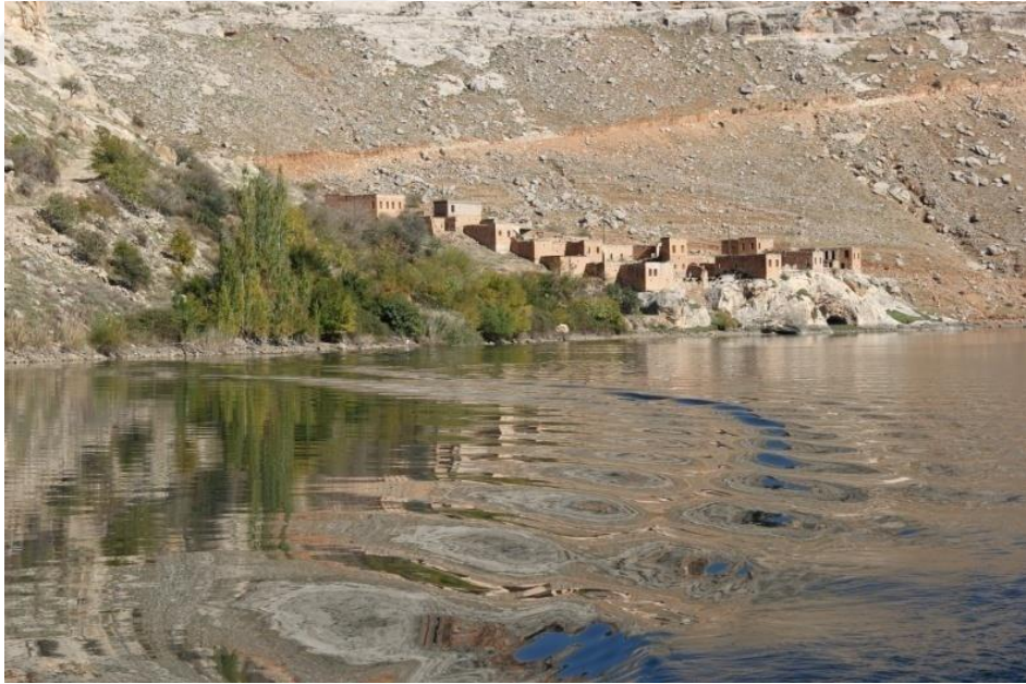
Şekil 4.12. Baraj sularından etkilenen Nizip ilçesine bağlı Kamışlı köyü (Gören Mimarlık, 2014)
