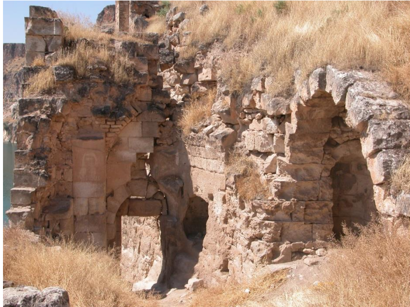
Şekil4.42. D01 kapısının içten görünüşü (Anonim, 2006)
