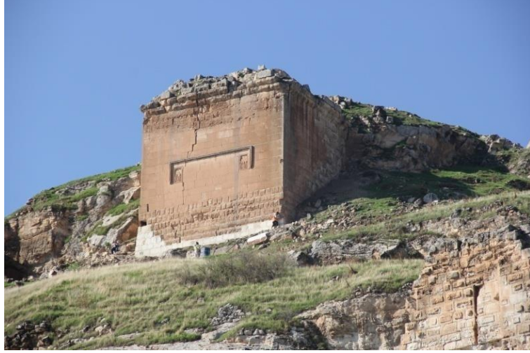
Şekil 4.35. Rumkale, Aziz Nerses Kilisesi doğu cephe genel görünüş (Gören Mimarlık, 2014)
