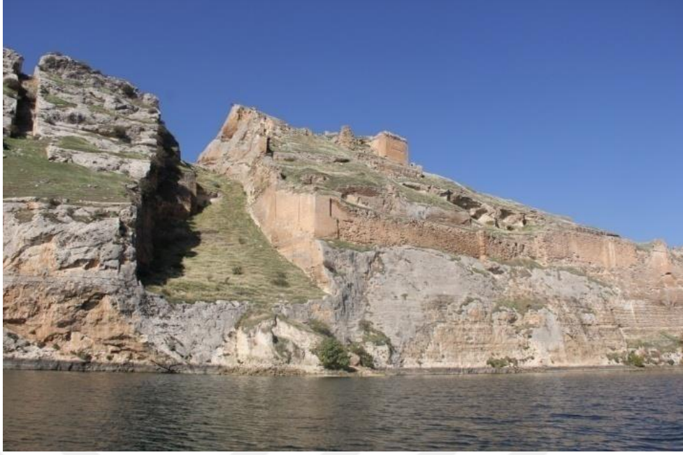
Şekil 4.34. Rumkale güney,hendek (Gören Mimarlık, 2014)
