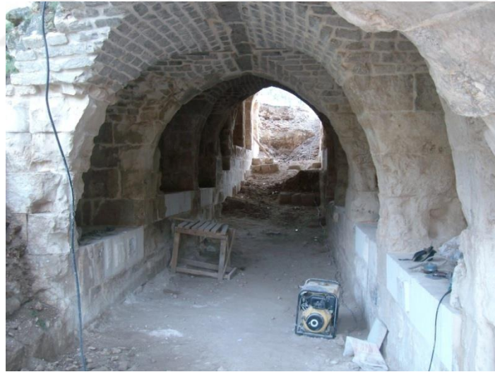
Şekil 4.57. B07 burcu 2009 yılı restorasyon çalışmaları sırasındaki görünüşü (Gören Mimarlık, 2009)
