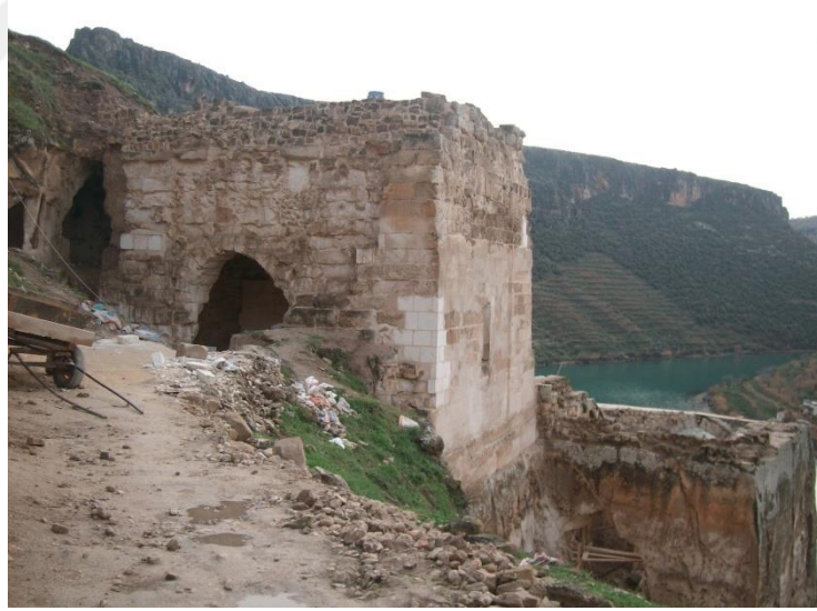
Şekil 4.55. B06 kapısı 2009 yılı restorasyon çalışmaları sırasındaki görünüşü (Gören Mimarlık, 2009)
