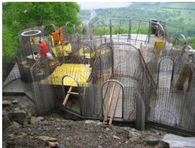
Şekil 3.17 Yeryüzü evlerinin metal konstrüksiyonu [81]
