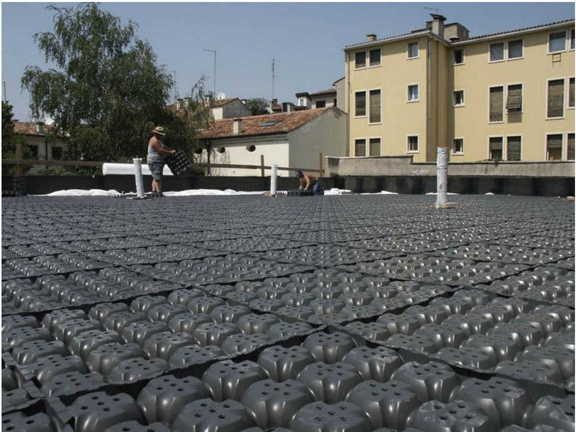
Şekil 3.7 Drenaj tabakasında kullanılan plastik esaslı modüler sistemlere bir örnek [70]
