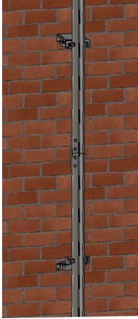
Şekil 7.10 : Kılavuz ray sistemi montajı
