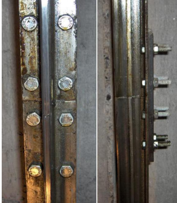
Şekil 3.6 : İki rayın birbirine montajı
