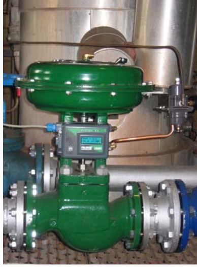
Şekil 1.20 : Pnömatik aktuatörlü ve akıllı pozisyonerli glob kontrol vanası örneği.
