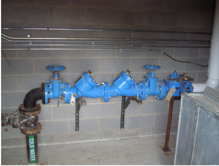
Şekil 1.39 : İkili çekvalf montajı örneği [62].
