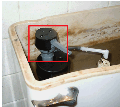
Şekil 1.36 : Sifonlarda kullanılan şamandıralı valf örneği [57].
