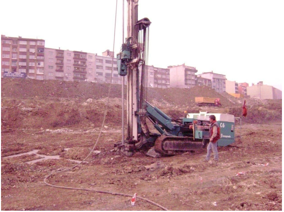
Şekil 2.13 : Çift akışkanlı jet grout uygulaması
