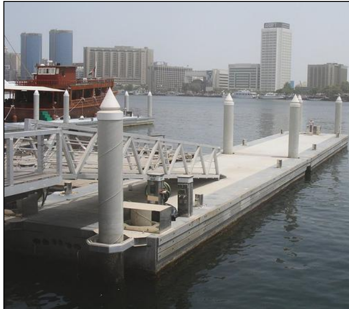
Şekil 3.2: Yüzer sistem beton iskele
