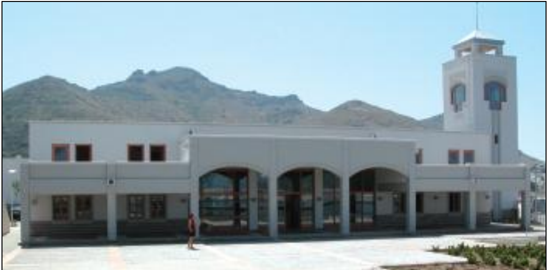
Şekil 4.20: D-Marin Turgutreis Marina yönetim binası
