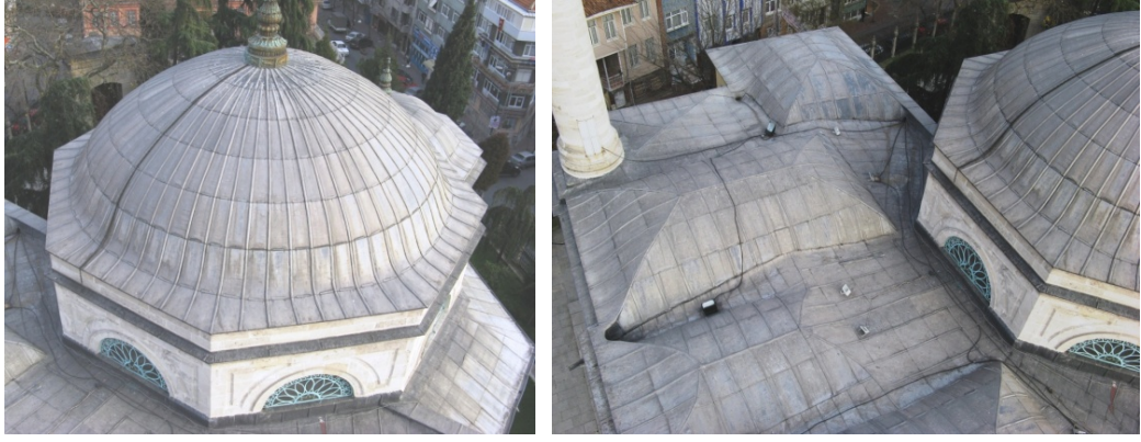
Şekil 5.3. Hırka-i Şerif Camii – Sekizgen Kaideye Oturan Kubbe ve Tonozların Minarenden Görünüşü
