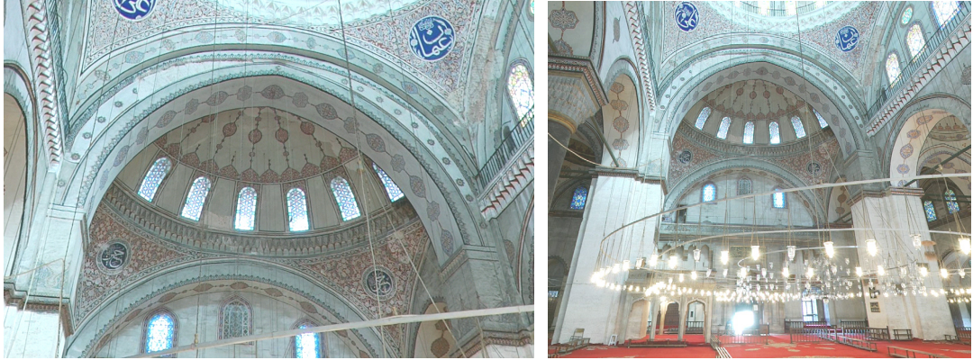
Şekil 1.1: İstanbul II. Beyazid Camii Ana Kemerinde Mimar Sinan Tarafından Yapılan Güçlendirme
