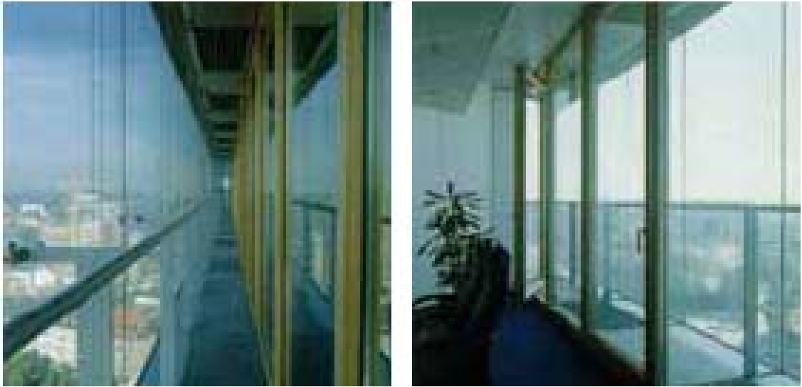
Şekil 4.5 Düsseldorf Citygate, Çift Cidarlı Cephe Örneği (Poirazis, 2003)
