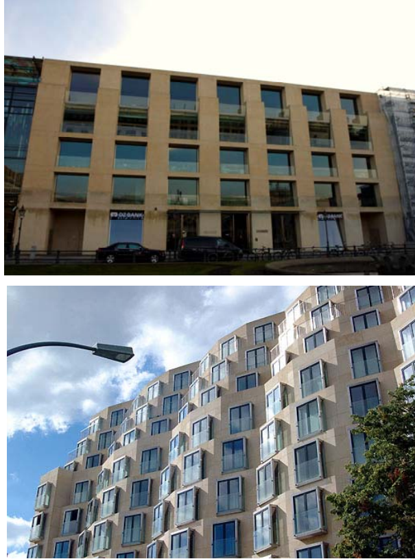
Şekil 5.8: DZ Banka Binası Cephe Görünüşü 14
