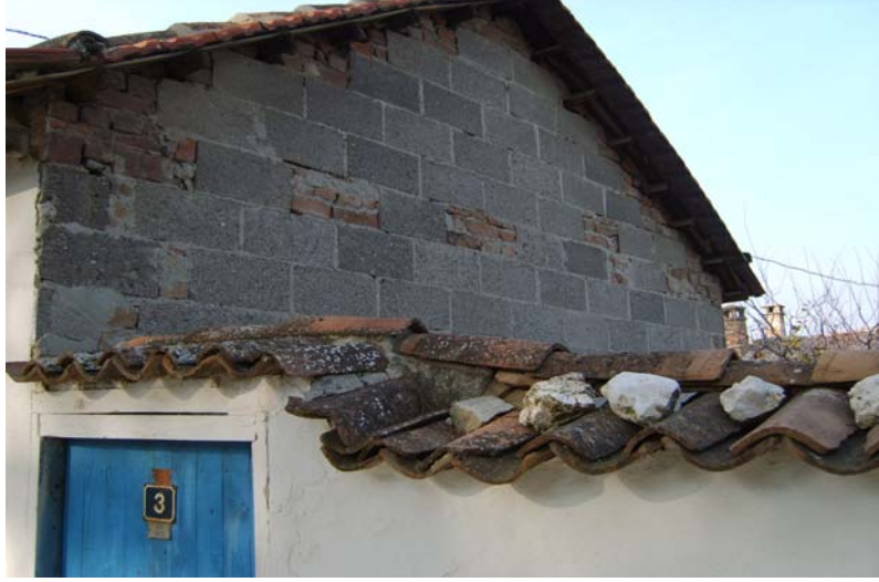
Şekil 2.3. Briket yığma duvar
