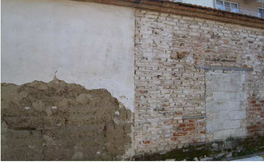
Şekil 2.26. Yan yana duran kerpiç ve tuğla duvarlı binalar (Manisa – Muradiye)
