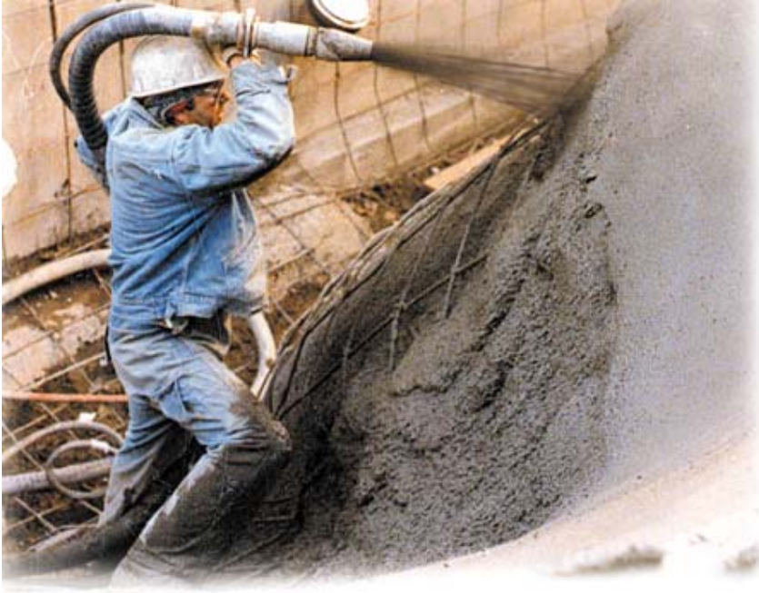
Şekil 6.6. Püskürtme beton uygulaması
