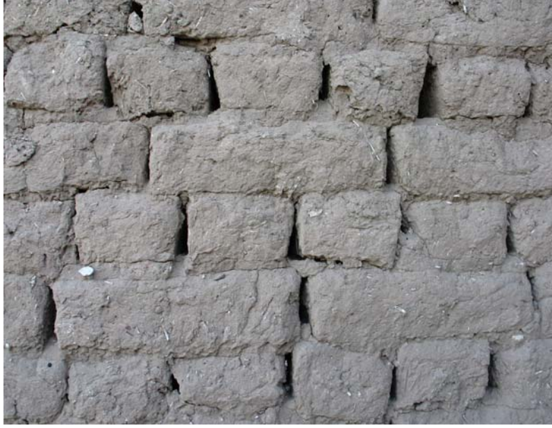
Şekil 2.13. Örölmüş kerpiç duvar (Saruhanlı/Manisa)
