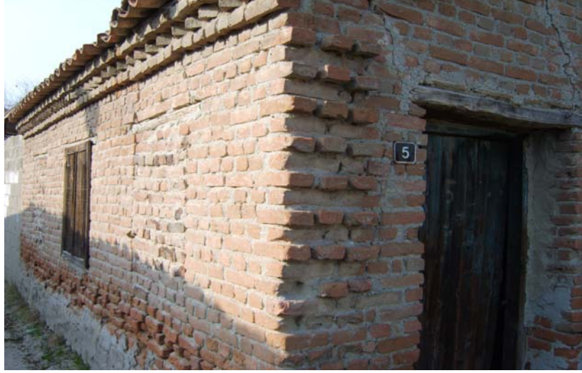
Şekil 2.2. Tuğla yığma duvar
