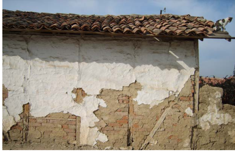
Şekil 2.17. Dilmelerle güçlendirilmiş “çatma duvar” örneği (Belen/Manisa)
