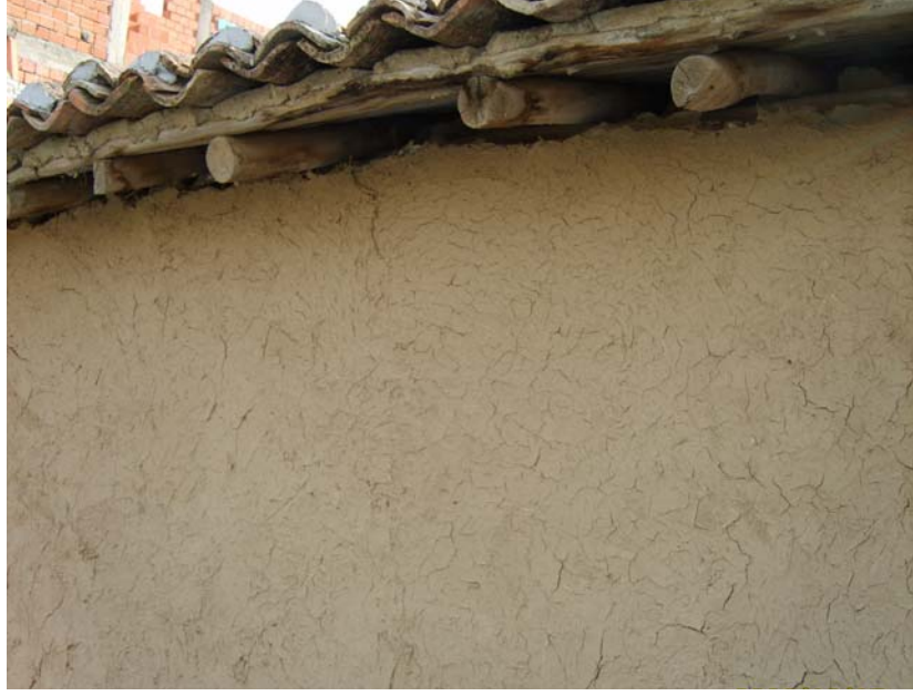
Şekil 2.14. Kerpiçle yapılan sıva (Hacırahmanlı/Manisa)
