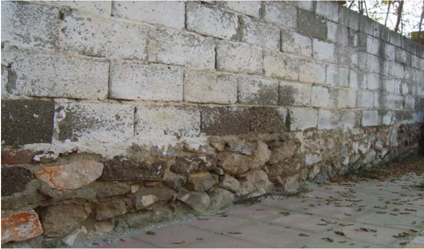
Şekil 2.27. Briket duvar altı taş temel (Manisa – Akhisar)
