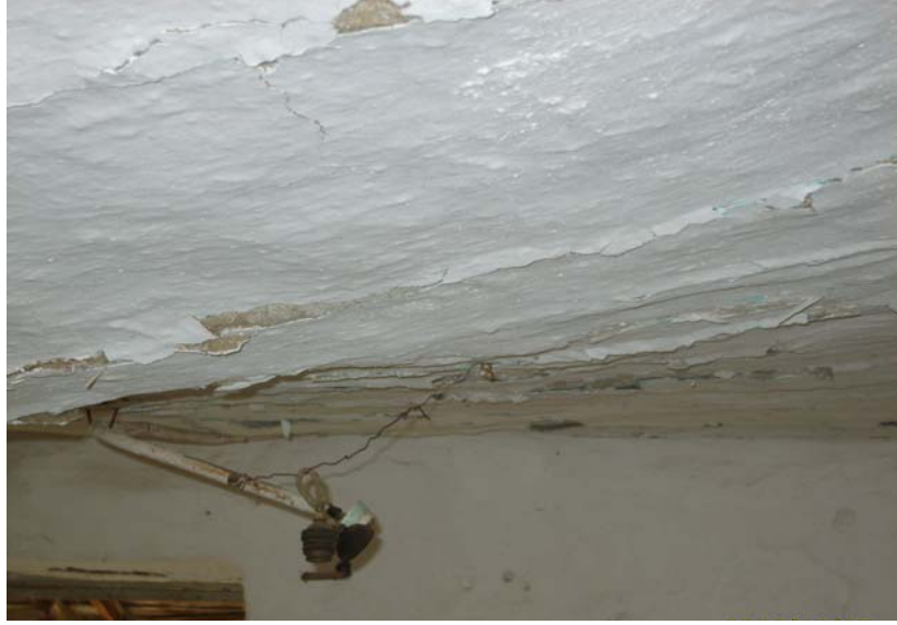
Şekil 2.19. Kerpiçten yapılmış çatı sistemi (Demirci/Manisa)
