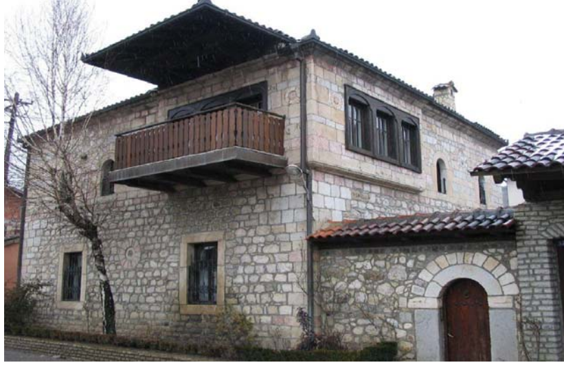
Şekil 2.5. Taş yığma duvar
