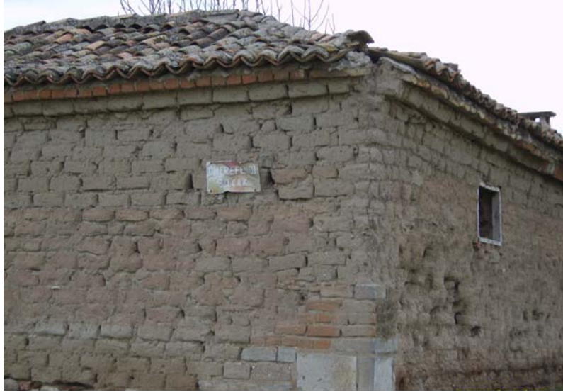
Şekil 2.4. Kerpiç duvar
