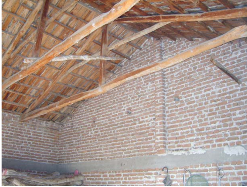
Şekil 2.18. Kavak ağacından yapılmış çatı kafes sistemi (Akhisar/Manisa)
