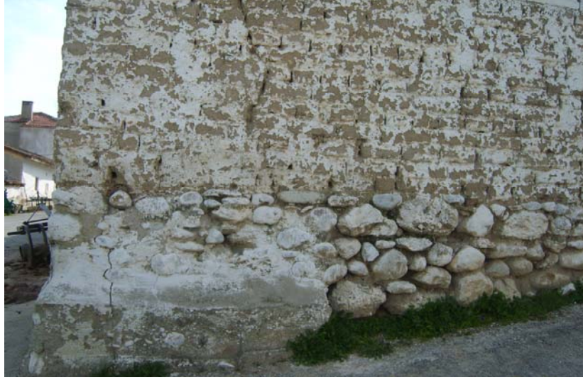
Şekil 2.12. Taş temele sahip kerpiç yapı örneği (Saruhanlı/Manisa)
