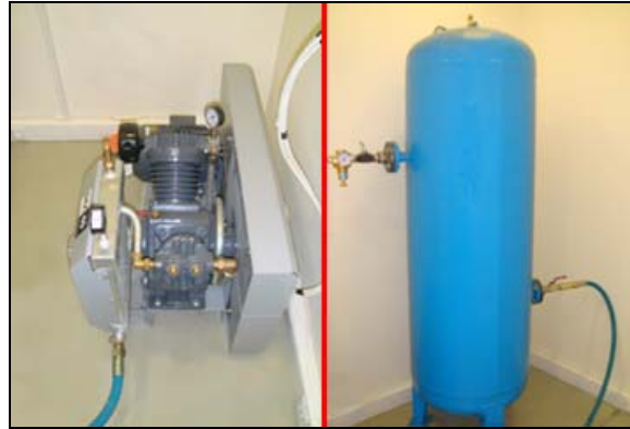
Şekil 5.2 : Kompresör ve basınç tankı.
