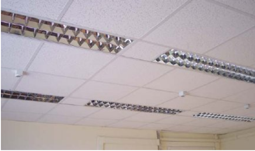
Şekil 3.2. Armatürler ve kontrol sistemi ışık algılayıcılarının tavanda yerleşimi
