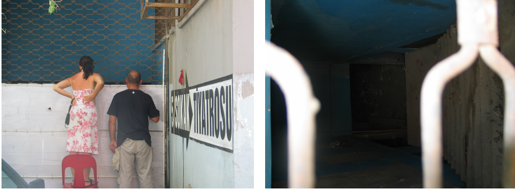
Şekil 5.5 : Antalya'daki garajın kapatılmasından sonraki hali
