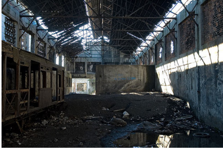
Şekil 5.20 : Hasanapaşa Gazhanesi iç görünüm
