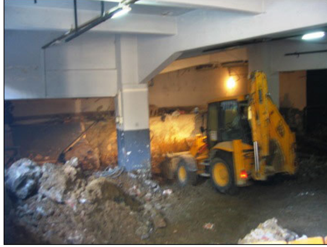
Şekil 5.3 : Garajistanbul zeminin kazılma aşaması
