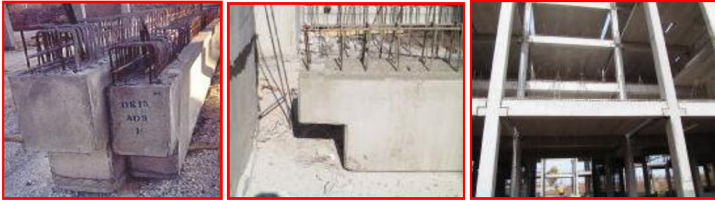
Şekil 6.1. İnceltilmiş uçlu prefabrike kiriş ve birleşimi
