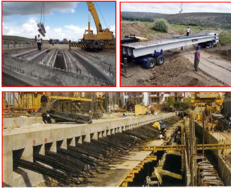
Şekil 2.8. Öngerilme ve ard gerilmeli beton uygulamaları
