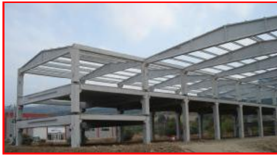
Şekil 1.2. Prefabrikasyon teknolojisi ile üretilmiş endüstriyel yapı
