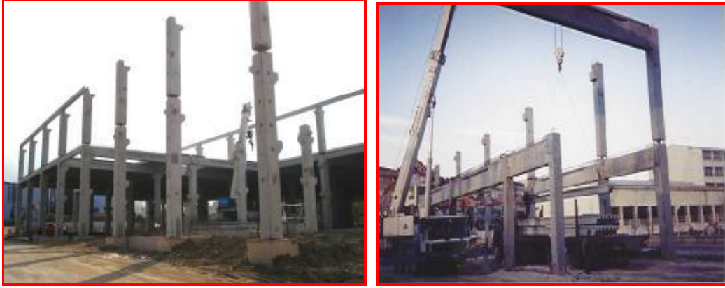
Şekil 2.5. Prefabrike ıslak birleşimli taşıyıcı sistem montajı
