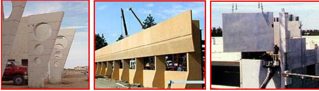
Şekil 1.3. Prefabrike elemanların fabrikada imalatı sonrası yerine montajı
