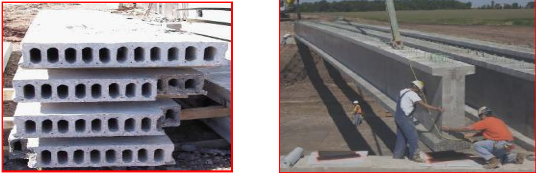
Şekil 1.4. Prefabrike öngerilmeli döşeme plakları ve prefabrike öngerilmeli köprü kirişleri
