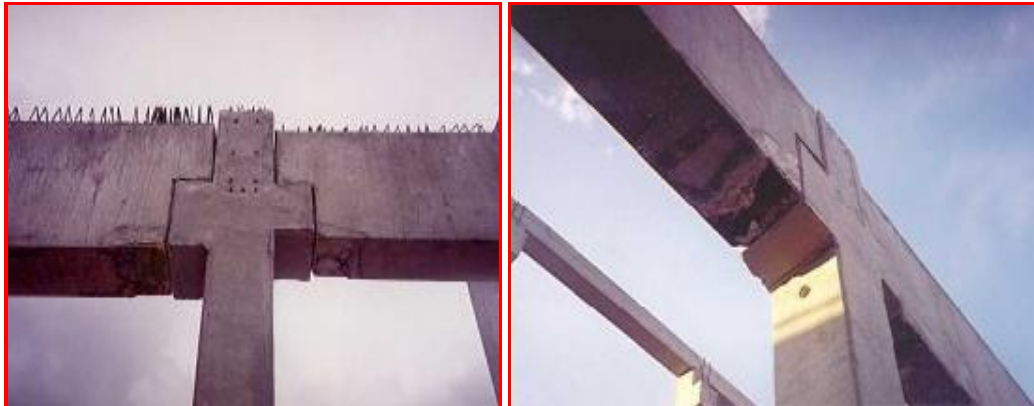
Şekil 6.2. Kolon-kiriş ıslak ve kuru birleşim detayı
