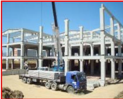
Şekil 1.1. Prefabrike endüstriyel yapı ve prefabrike köprü sistem
