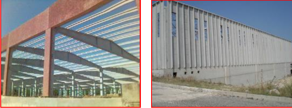
Şekil 2.1. Prefabrike endüstriyel yapı
