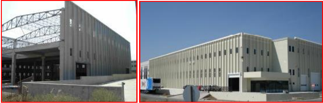
Şekil 2.2. Kalıcı prefabrike yapı
