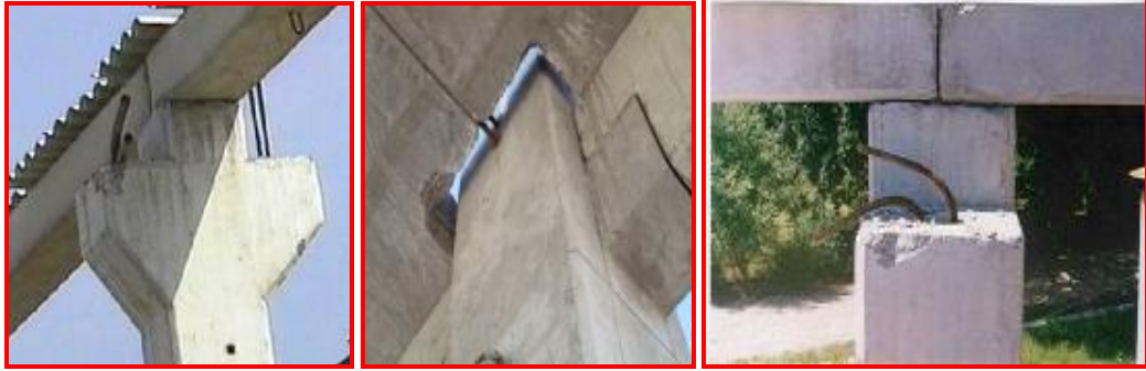
Şekil 6.4. Moment aktarmayan kolon – kiriş birleşimi
