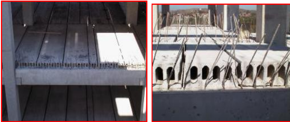
Şekil 3.5. Döşemelerin kirişlere montajı
