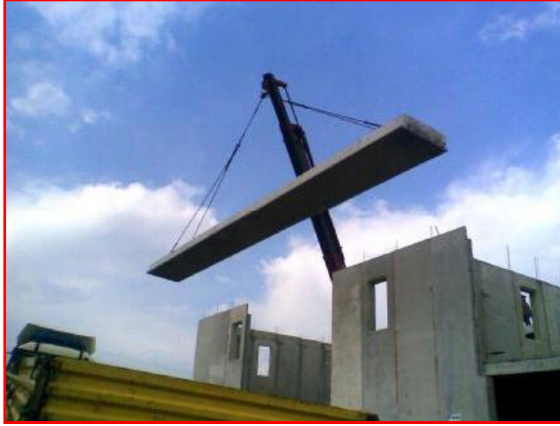
Şekil 4.1. Büyük boy panellerle oluşturulmuş yapı sistemi
