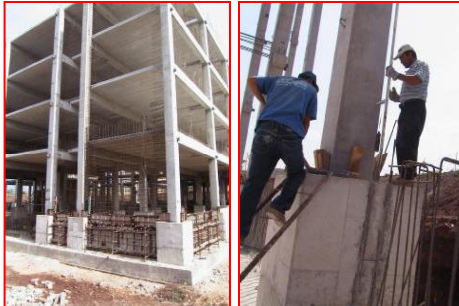
Şekil 5.5. Yuvalı temel yükleme modeli ve imalat resmi
