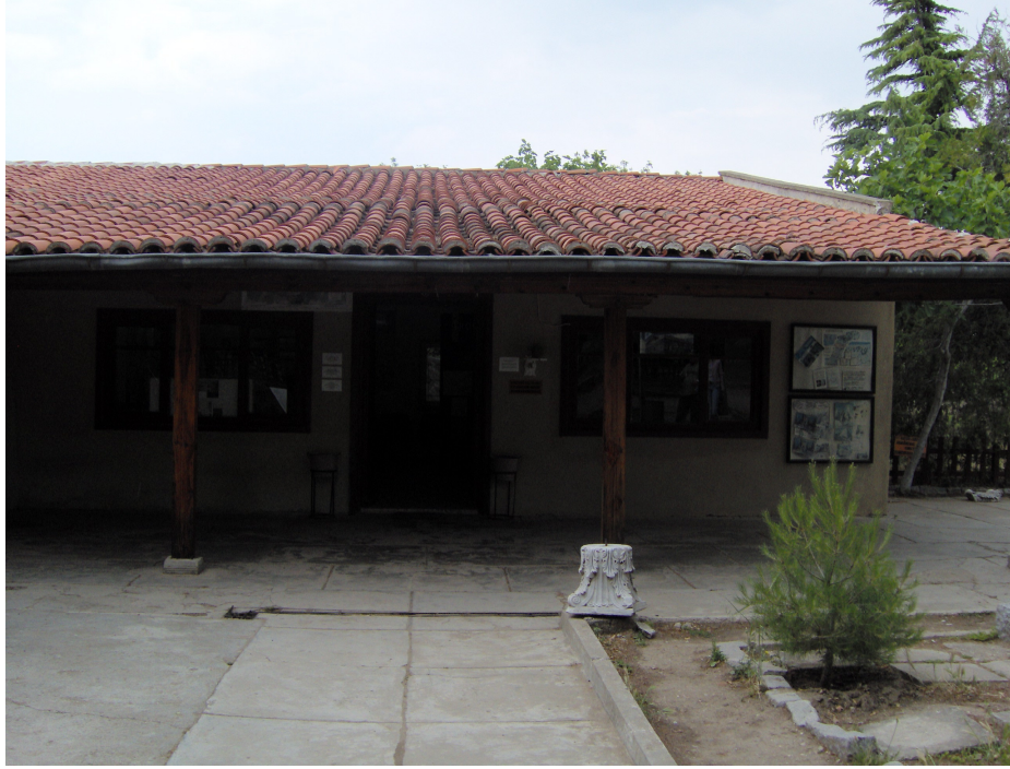
Resim 21: Troya Ziyaretçi Bilgilendirme Merkezi Binası (Serkan ATALAY Arşivi)
