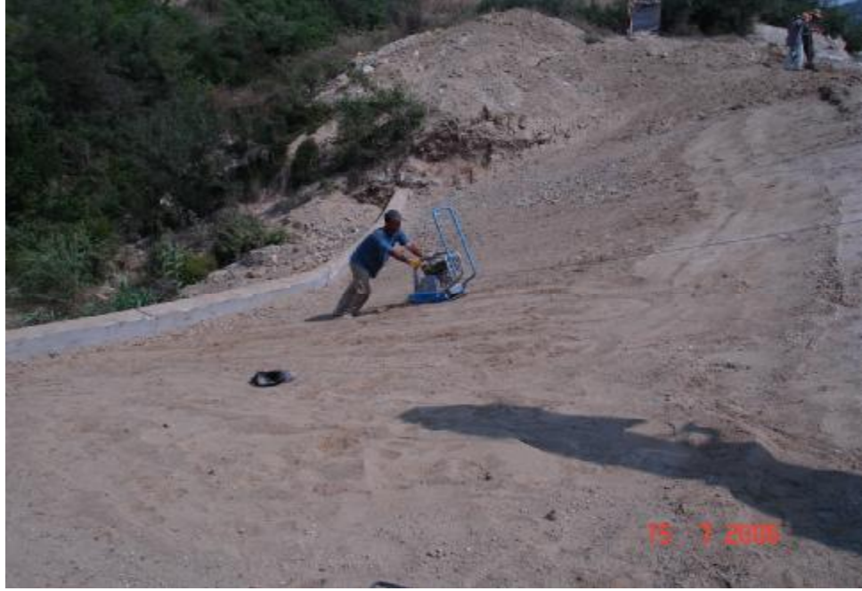
Şekil 4.20. Düzeltilen yamaçların vibratör ile sıkıştırılması.
