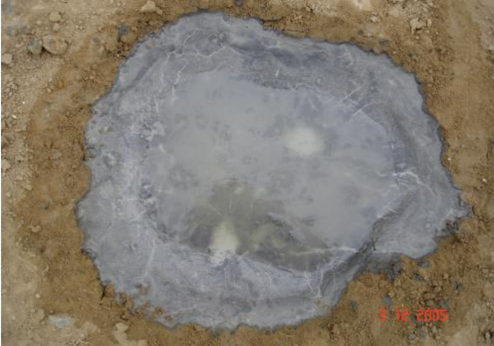
Şekil 4.15. Enjeksiyon yapılan bir nokta.
