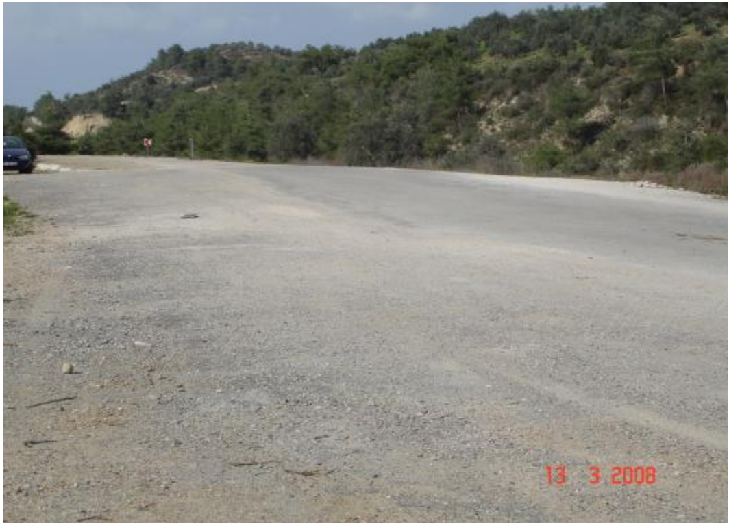
Şekil 4.12. Dolgu yüzeyindeki oturmalar
