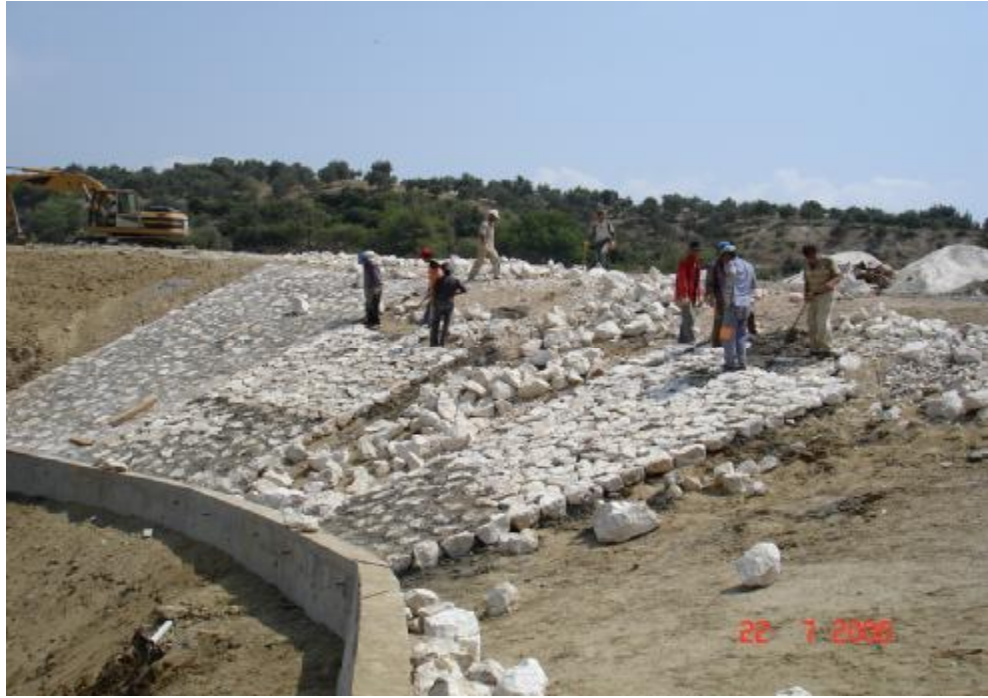
Şekil 4.21. Perde duvar ile yol arası şevlere harçlı taşpere yapılması.
