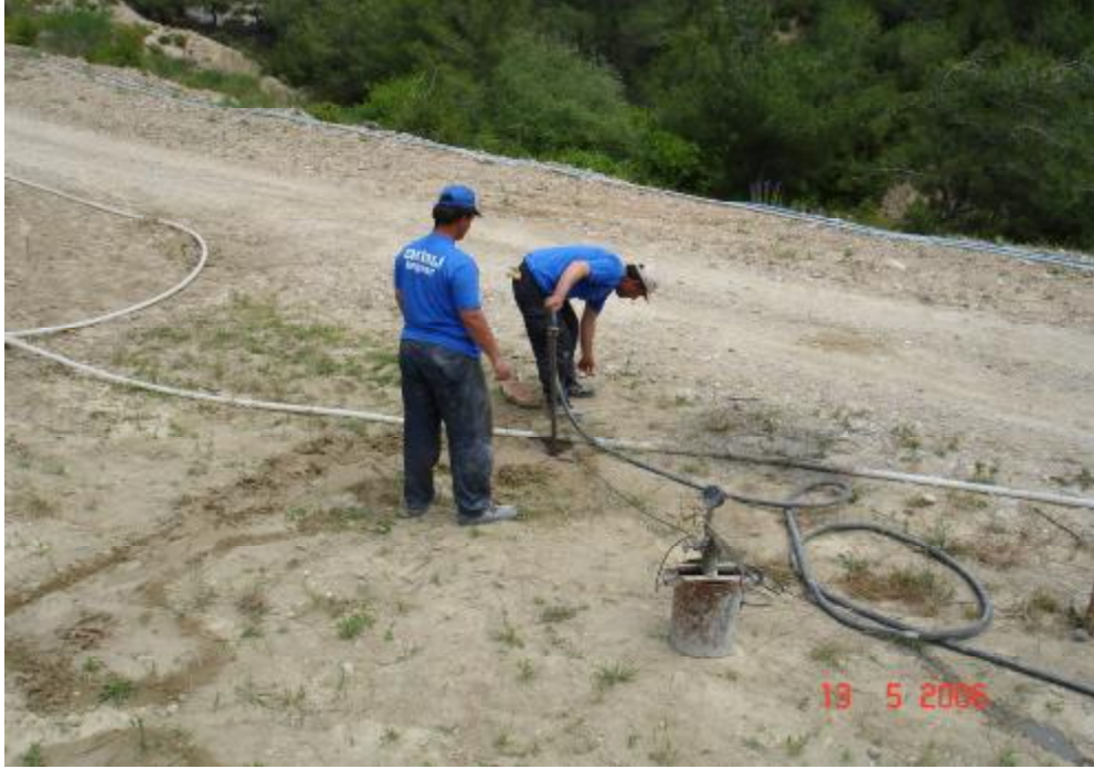
Şekil 4.14. Çalışma alanından enjeksiyon yapılmasına bir örnek.
