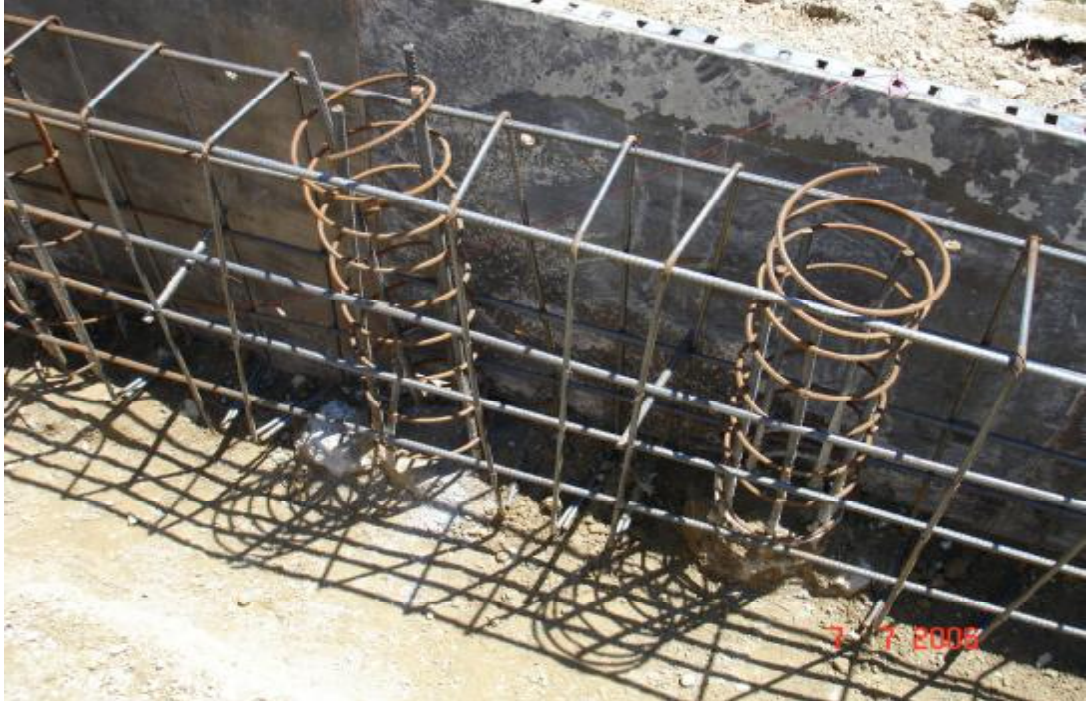
Şekil 4.19. Perde duvarın demirlerinin bağlanması ve kalıplarının takılması.
