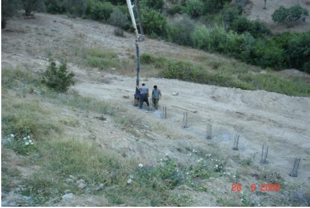
Şekil 4.18. Açılan çukurların demir donatıları indirildikten sonra hazır betonla doldurulması.
