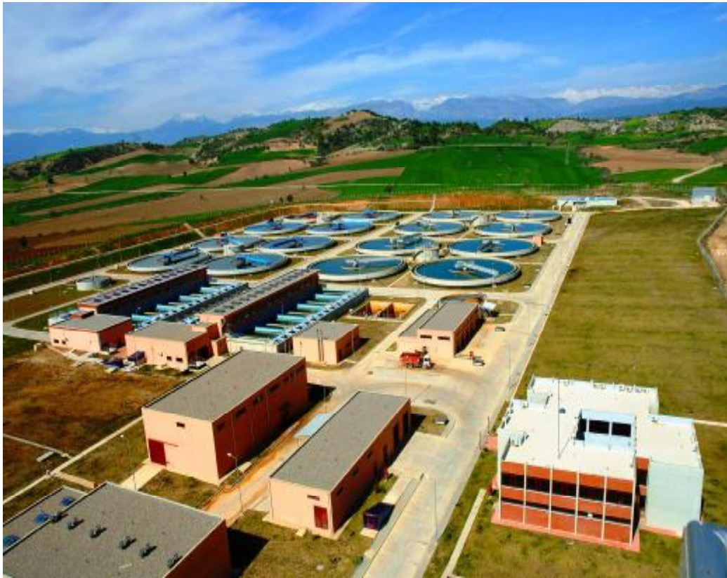
Şekil 1.2. Çatalan içmesuyu arıtma tesisi.
