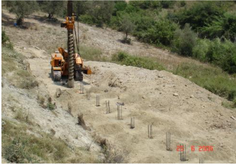
Şekil 4.17. Çalışma alanında kazıkların yapılması.
