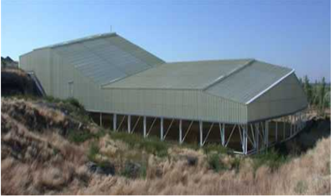
a: Güney Açması Çatı Kaplama Çalışmaları (Dış Görüntü).
