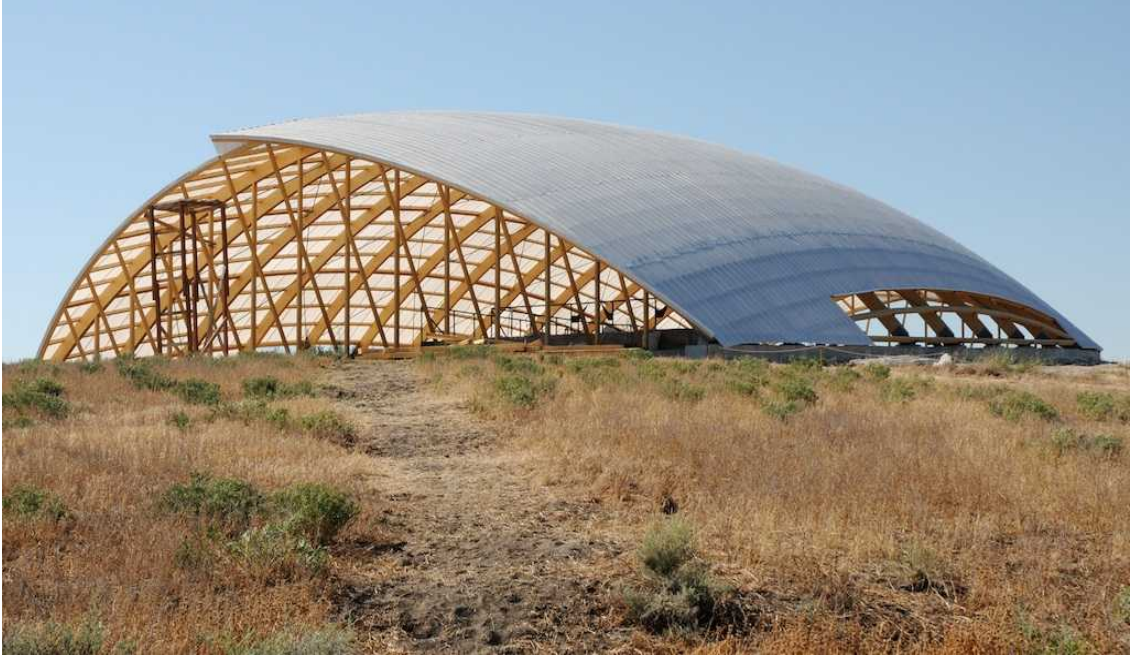
a: Çatı Kaplama Çalışmaları (Dış Görüntü).
