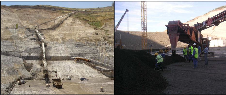
Şekil 6.5. İletici bantlarla getirilen SSB'nin dağıtılması
