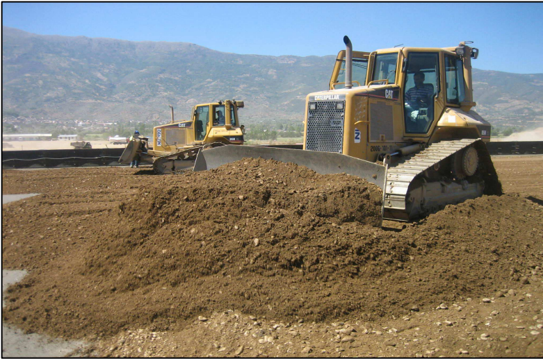
Şekil 6.8. SSB serilmesi
