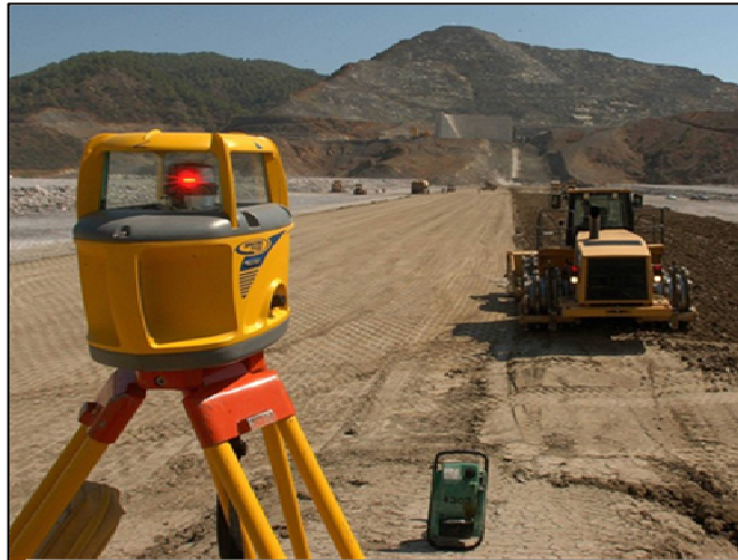
Şekil 6.6. Tabaka yüksekliğinin lazer ile kontrol edilmesi
