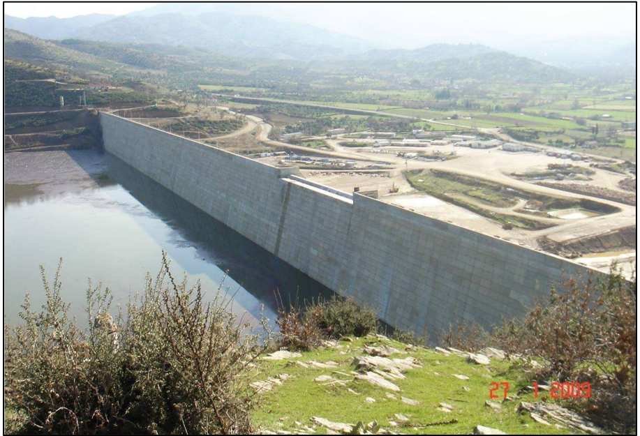
Şekil 2.1. Beydağ Barajı ( İzmir, Türkiye)
