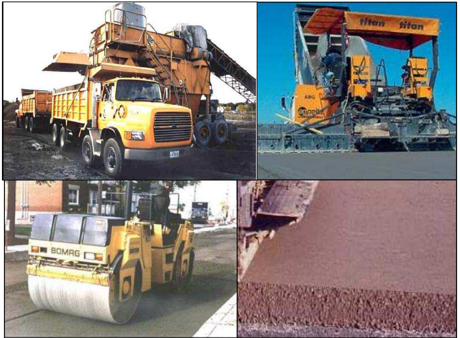
Şekil 2.2. Yol kaplamalarında SSB'nin taşınması, serilmesi ve sıkıştırılması
