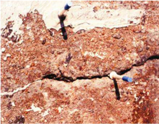
Şekil 1. Epoksi enjeksiyonu [11].
