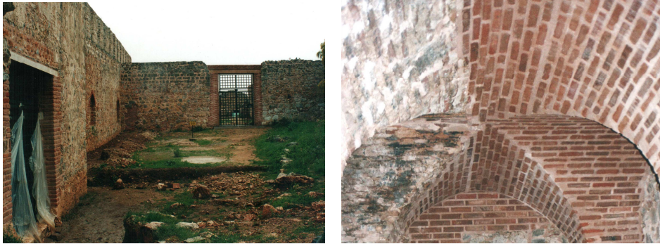
Şekil 3. Alanya Kalesi’nde farklı malzeme ile tamamlama yapılması
