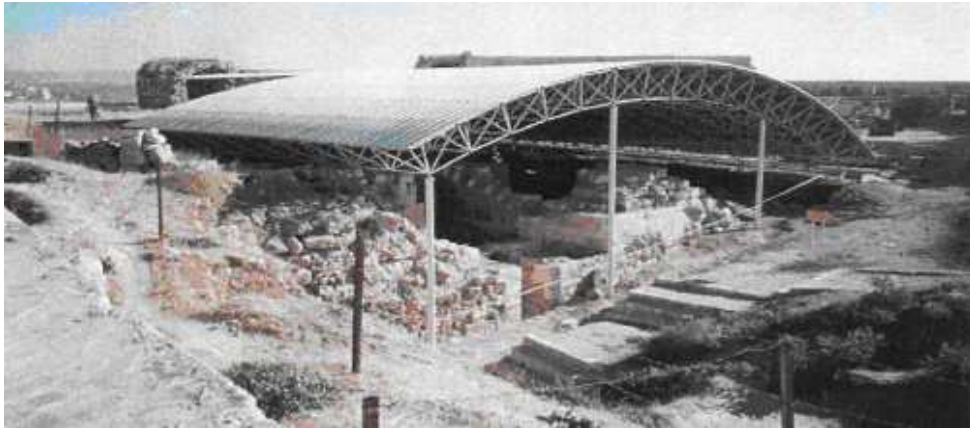
Şekil 4. Çelik konstrüksiyon koruma çatısı [13].
