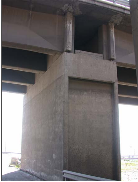
Şekil 6.2: Viyadük Deprem Takozu Görünümü
