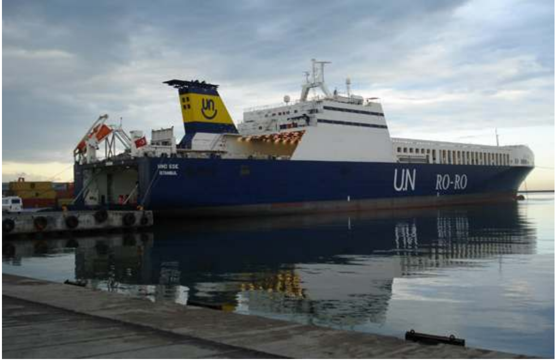
Şekil 4.7: Mersin Ro-Ro Terminali [62]
