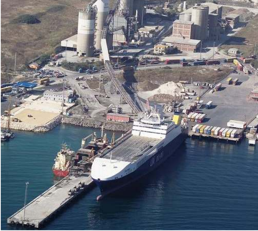
Şekil 4.3: Ambarlı Set Ro-Ro Terminali [73]
