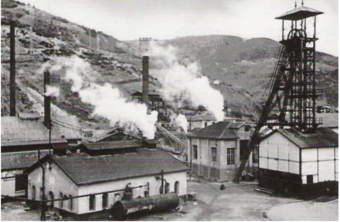
3.8. Türkiye İş Bankası' nın kuruluşu olan Kömür-İş 'in İncirharmanı Ocağı tesisleri.
