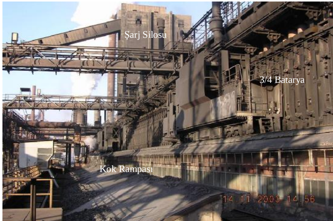
Şekil 1. 1. Kardemir A.Ş. kok bataryalarının görünüşü
