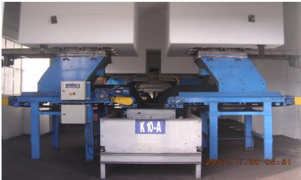
Şekil 1. 5. PLC kontrollü dozaj bantları ve K10A harman bandı
