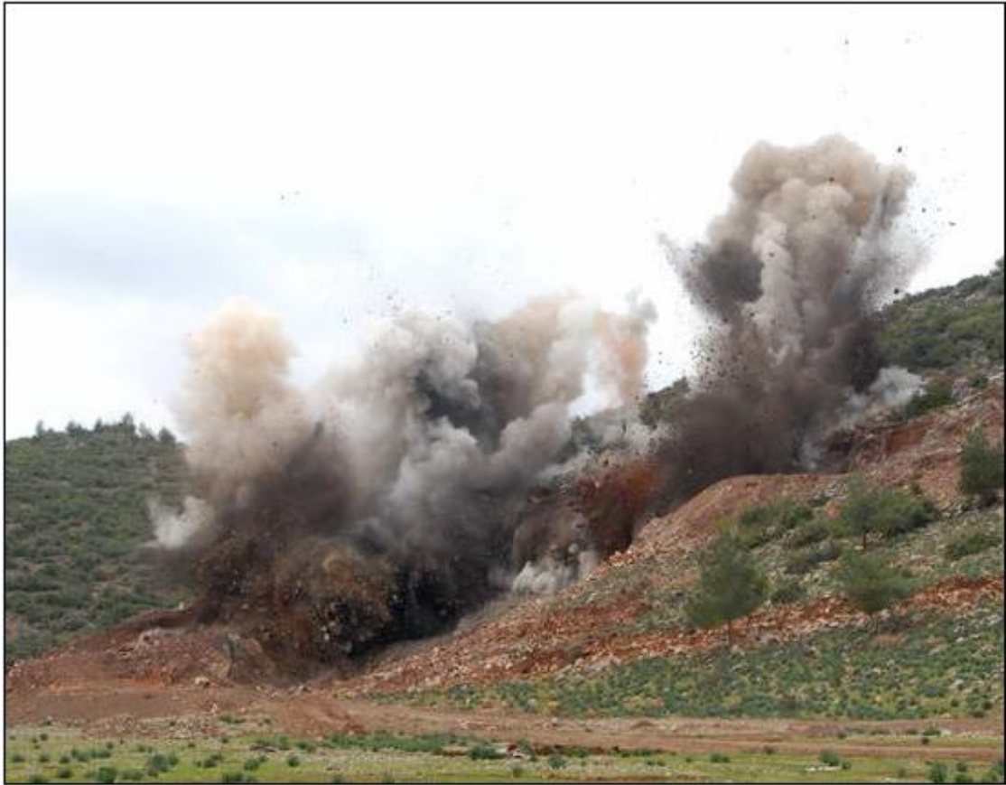
Şekil 3.6. Tesiste Yapılan Kaya Patlatma İşlemi Görüntüleri
