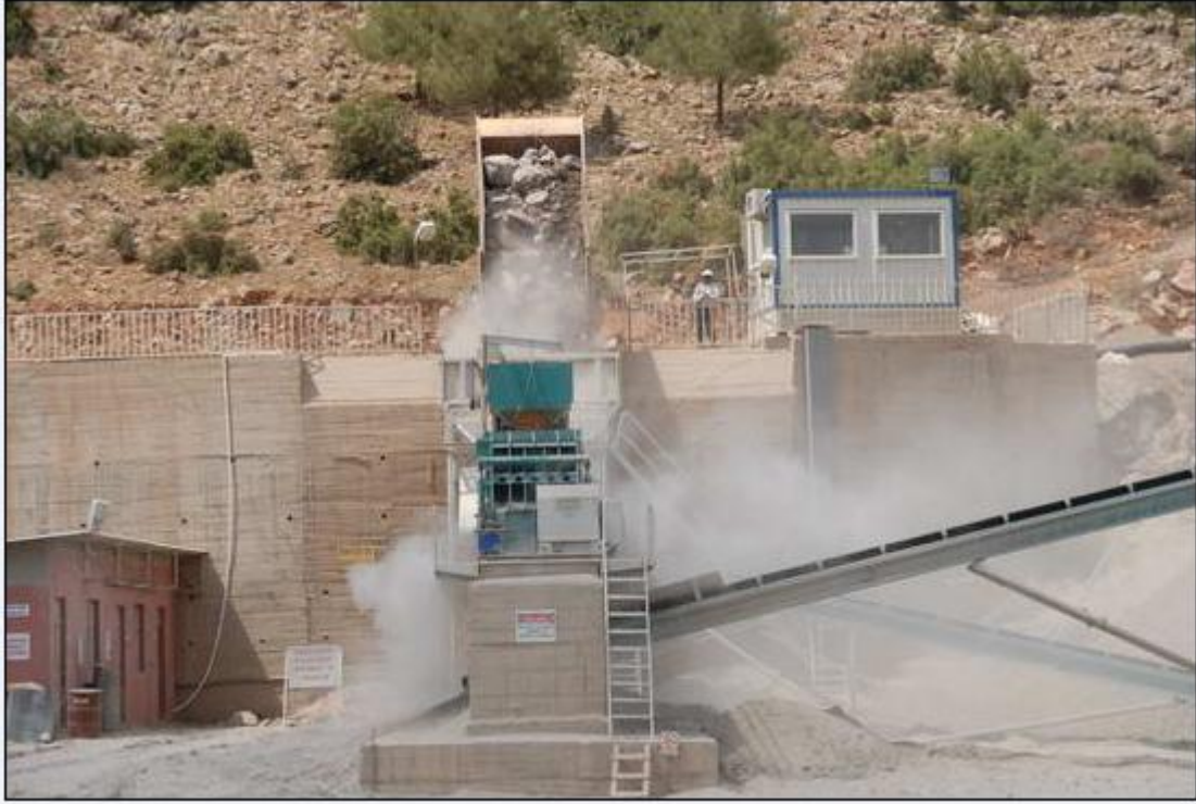
Şekil 3.7. Kahramanmaraş Belediyesi Kaya Kırma ve Eleme Tesisi Görüntüleri
