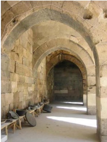
Resim 3.39: Sarıhan Kervansarayı İç Görünüşü. (Kaynak: http://www.ezberim.com/archive/t-85304.html )
