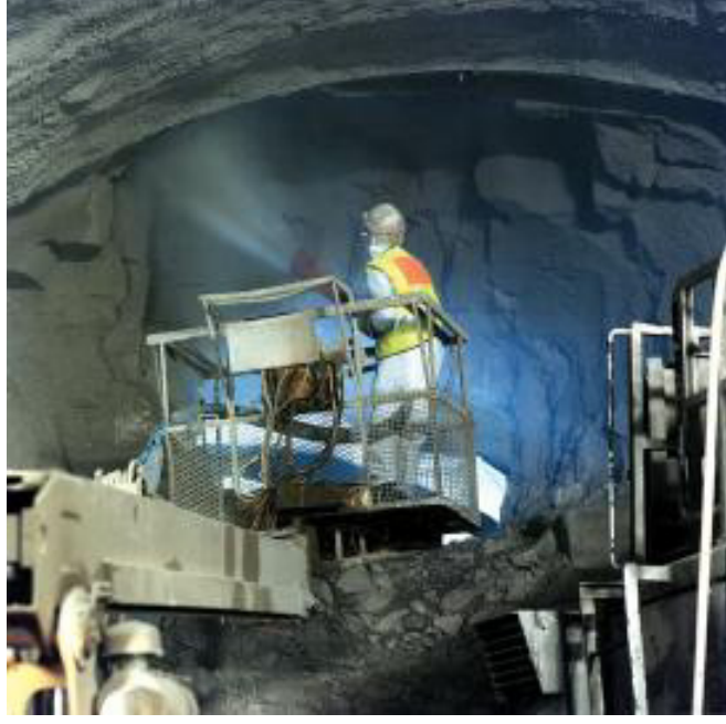
Şekil 3.8: Püskürtme beton uygulaması
