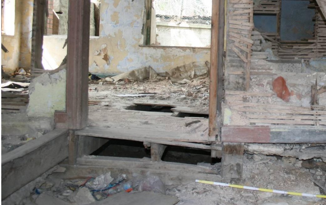
Fotoğraf 3.18 BB25 yapısında kapı altında yerleştirilen kirişleri desteklemek üzere eklenen taban takviyesi
