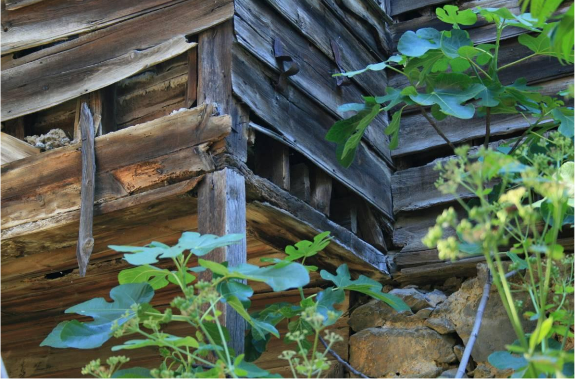
Fotoğraf 3.23 ÇK 29 yapısı tek tabanlı sistemlerde kiriş ve dikmelerin aynı tabana oturması
