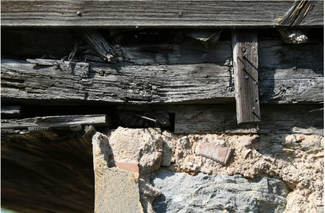
Fotoğraf 3.26 BB25 yapısında taban birleşimlerindeki bindirme detayı
