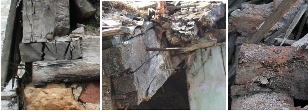
Fotoğraf 3.12 Taşıyıcı elemanlarında raptedilmesinde kullanılan örnekler
