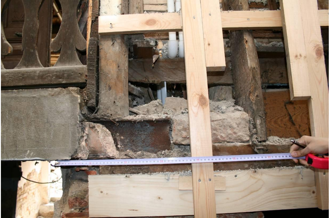
Fotoğraf 3.33 BB57 yapısında volta döşeme
