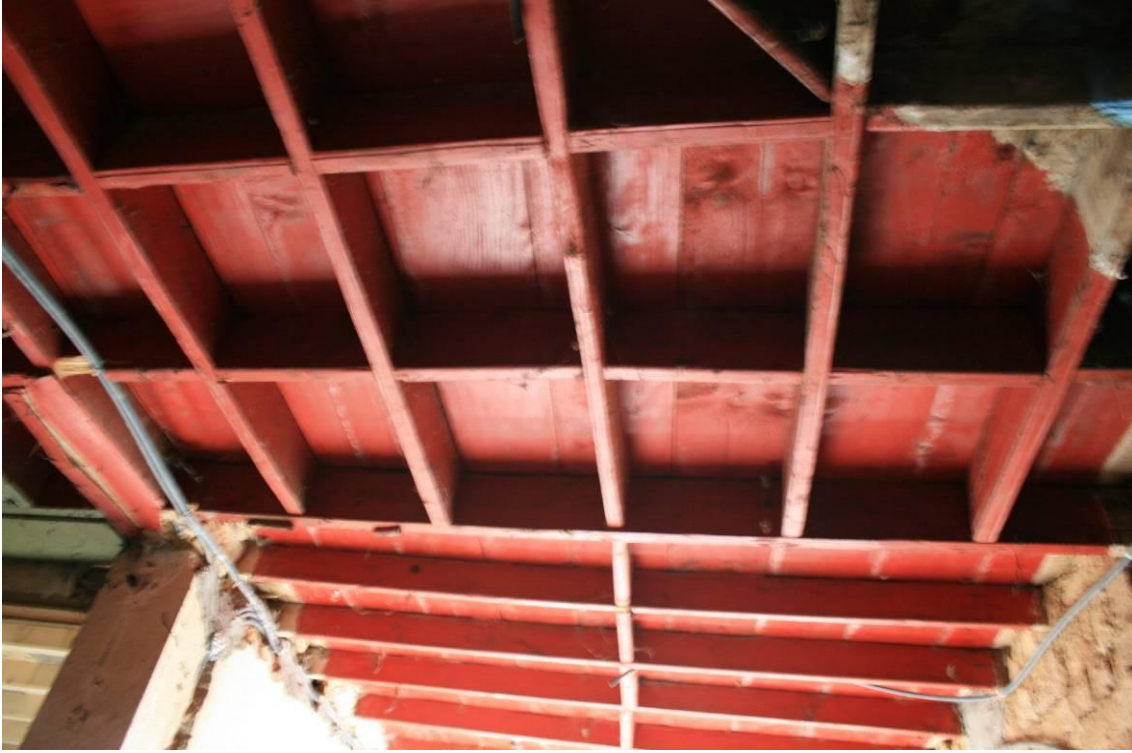
Fotoğraf 3.38 BB57 yapısı zemin kat tavanını oluşturan kirişler
