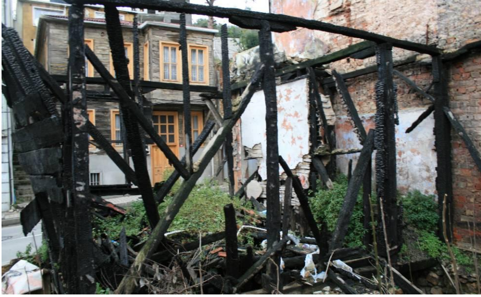
Fotoğraf 3.30 BB46 yapısı yangından sonra ayakta kalan taşıyıcı sisteminde bir ritimle sıralanmış ana dikmeler
