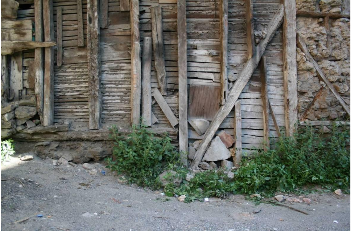
Fotoğraf 3.22 ÇK03 yapısında taban – temel duvarı ilişkisi
