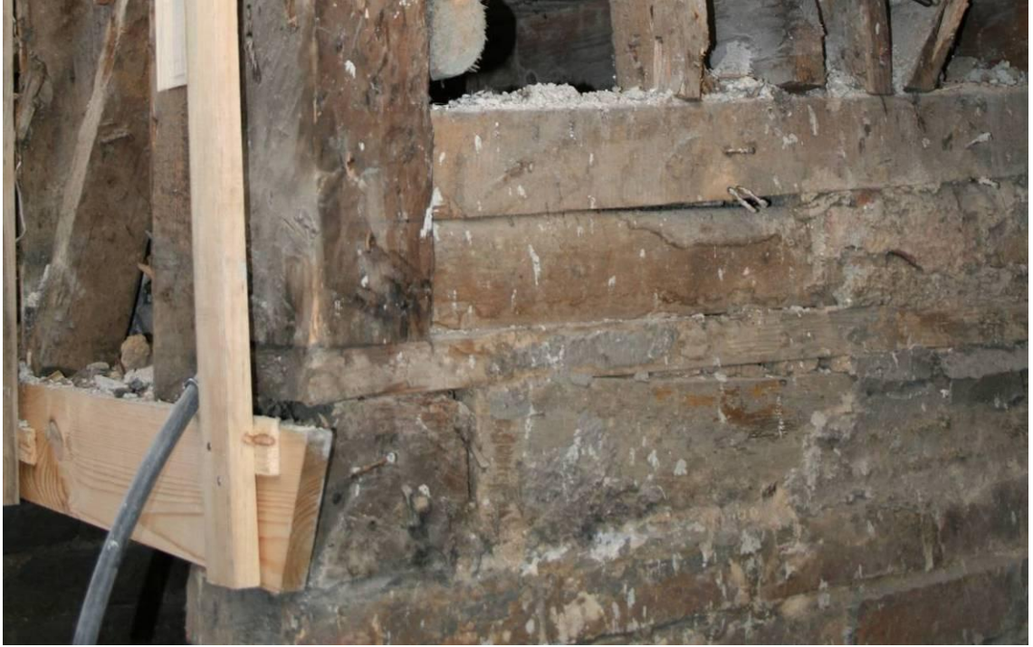
Fotoğraf 3.21 BB57 yapısında ahşap taban takviyesi
