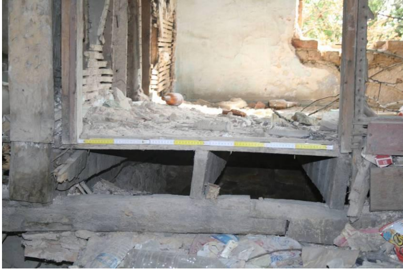
Fotoğraf 3.15 BB25 yapısı zemin kat tabanı bağlantısı
