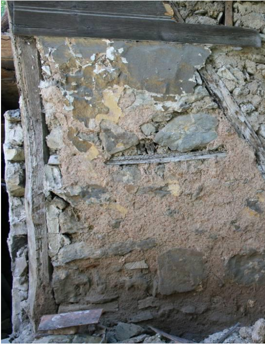
Fotoğraf 3.41 BB04 yapısı dolgulu duvarlarda kuşak yerleşimi
