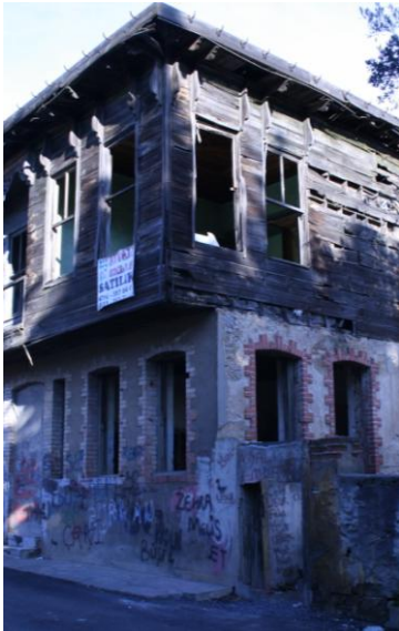
Fotoğraf 3.8 BB25, BB26, BB15 yapılarında konsol çalışan çıkmalar
