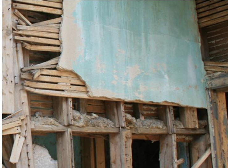
Fotoğraf 3.5 BB47 yapısında bağdadi çıtalarının yerleştirilmesinde düz bir yüzey temini için taşıyıcılara eklenen ahşap parçalar
