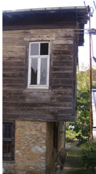
Fotoğraf 3.8 BB25, BB26, BB15 yapılarında konsol çalışan çıkmalar
