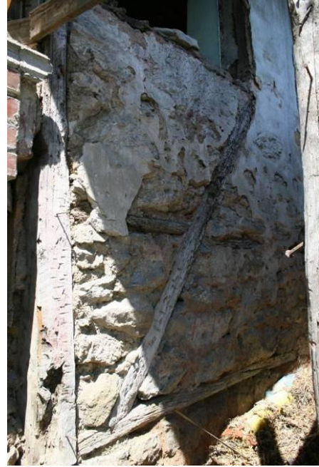
Fotoğraf 3.16 BB25 yapısında iki taban ve ana dikme ve payanda birleşimi
