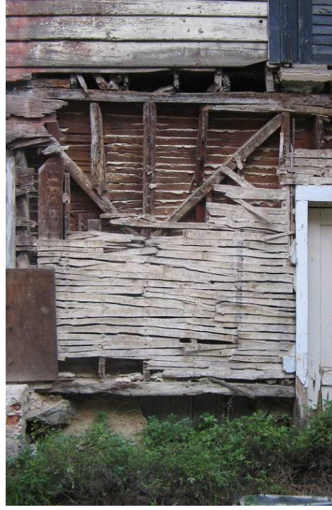
Fotoğraf 3.19 BB46 yanmış olan yapının kalan kagir duvar üzerinde tabanların birleşimi
