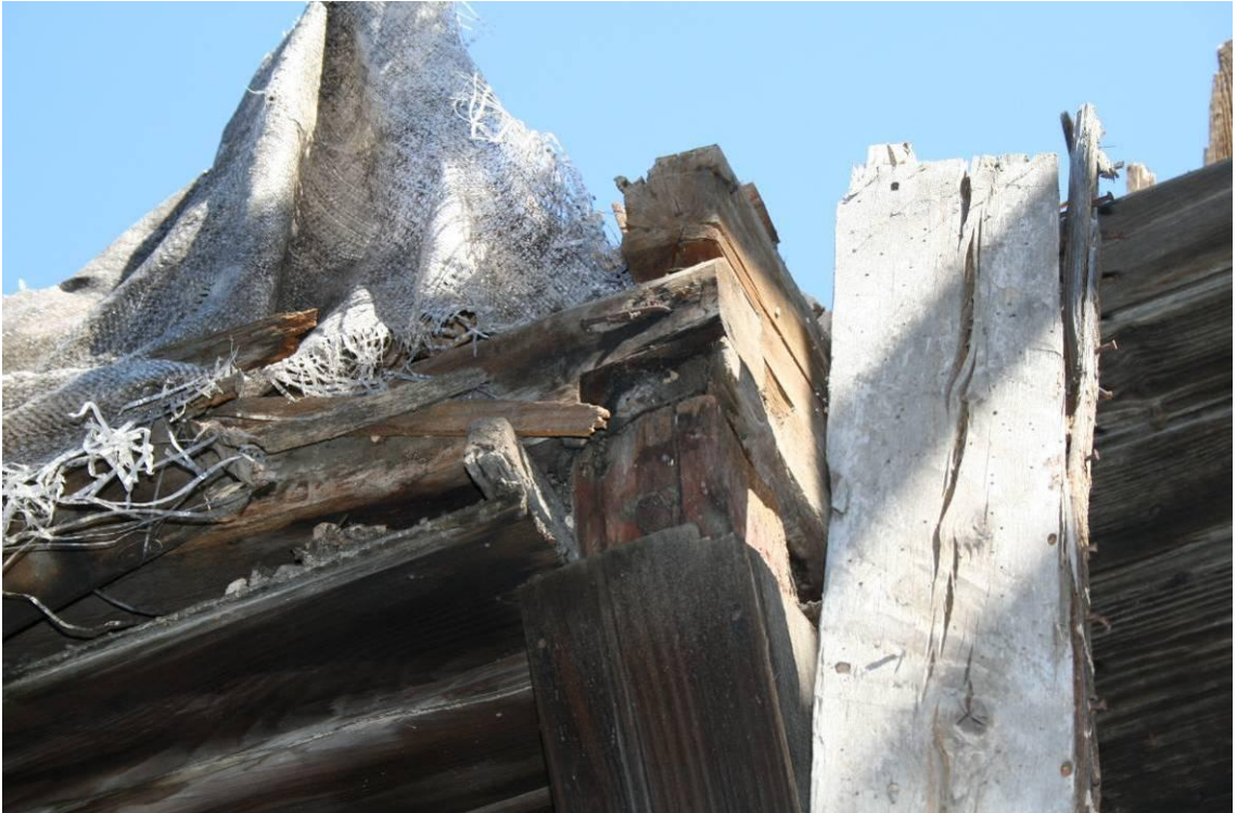
Fotoğraf 3.28 BB04 yapısında taban birleşimlerindeki bindirme detayı
