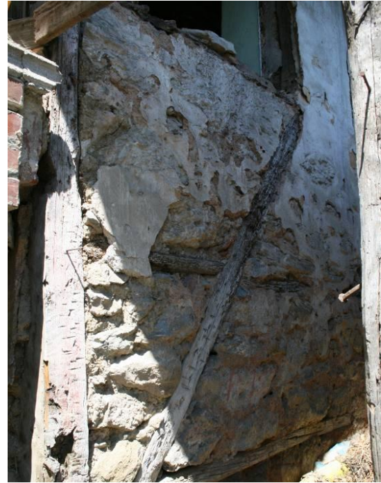
Fotoğraf 3.41 BB04 yapısı dolgulu duvarlarda kuşak yerleşimi
