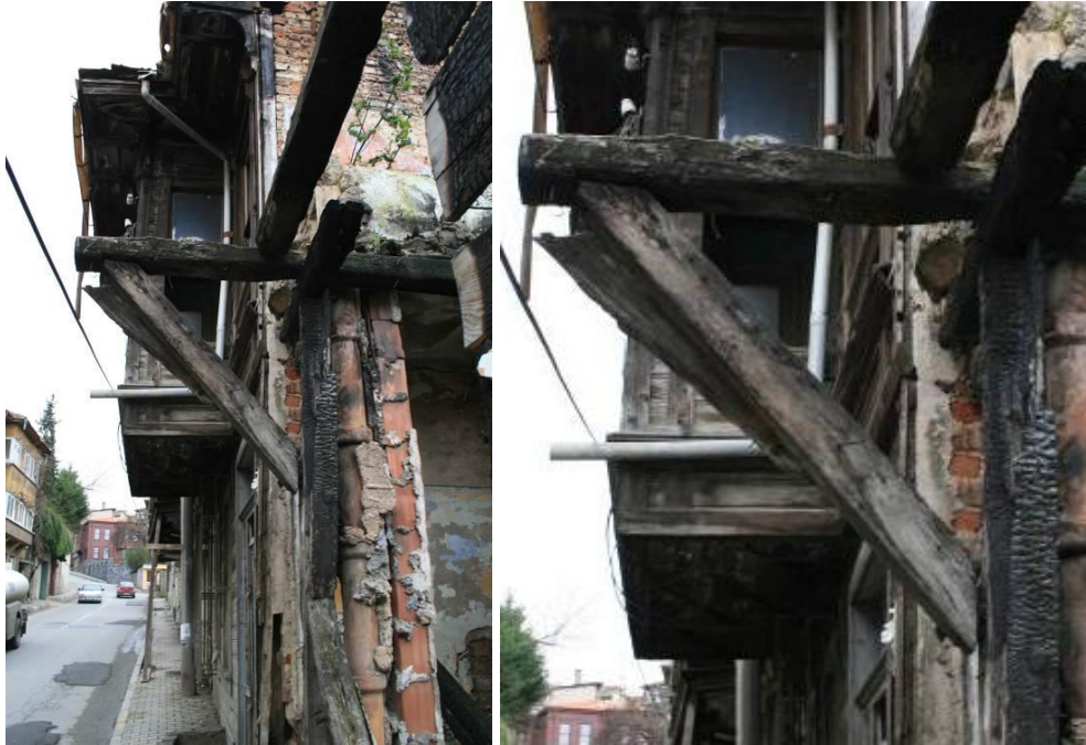
Fotoğraf 3.42 BB46 yapısında çıkma sistemi
