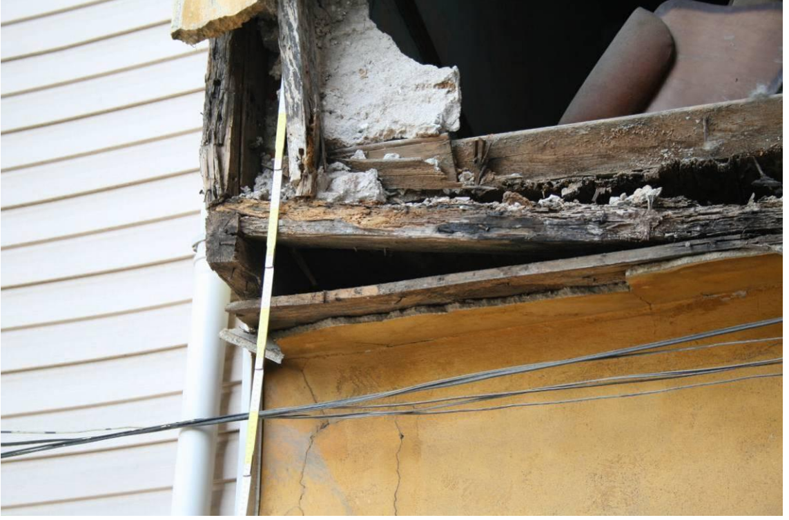
Fotoğraf 3.27 BB30 yapısında taban birleşimlerindeki bindirme detayı
