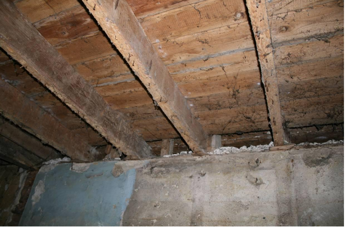
Fotoğraf 3.37 BB 44 yapısında kiriş-kagir bodrum duvarı ilişkisi
