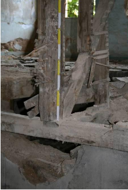
Fotoğraf 3.16 BB25 yapısında iki taban ve ana dikme ve payanda birleşimi
