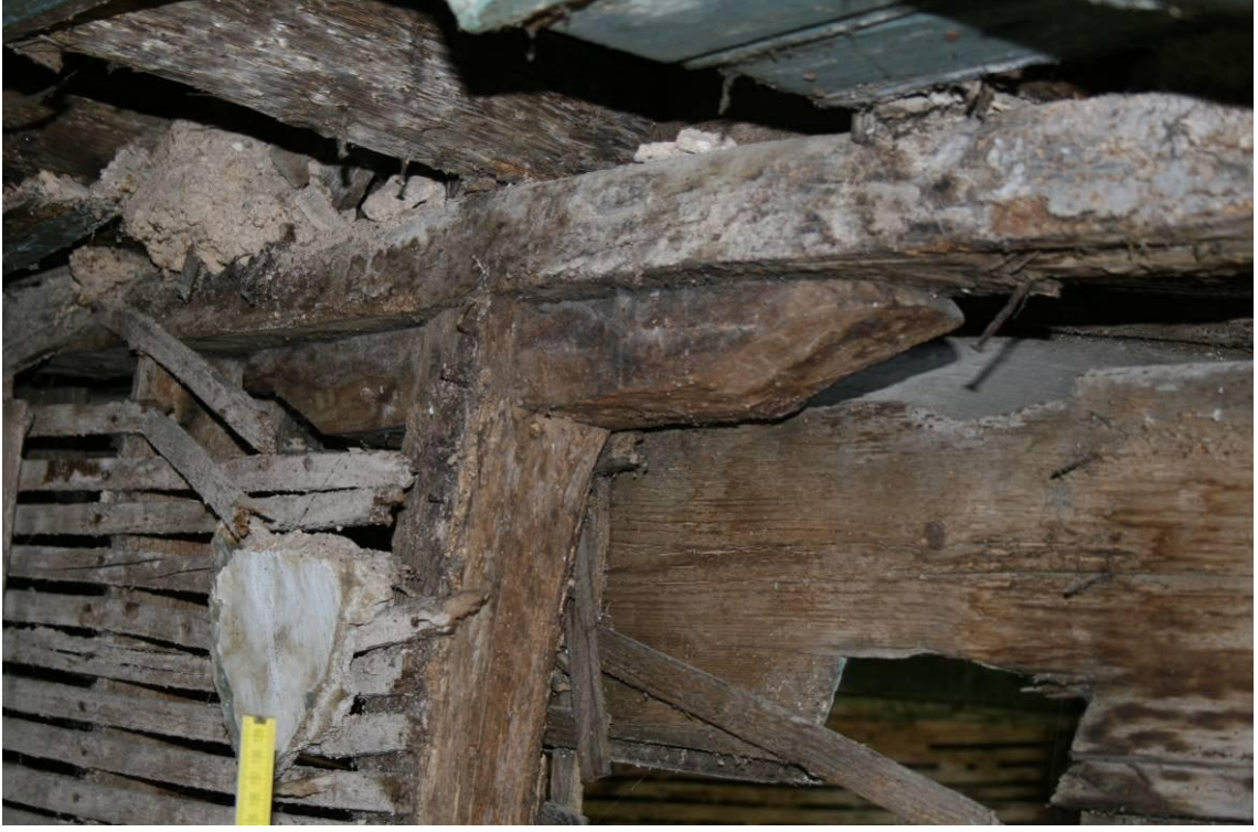
Fotoğraf 3.25 BB25 yapısında üst tabanın konumlanışı
