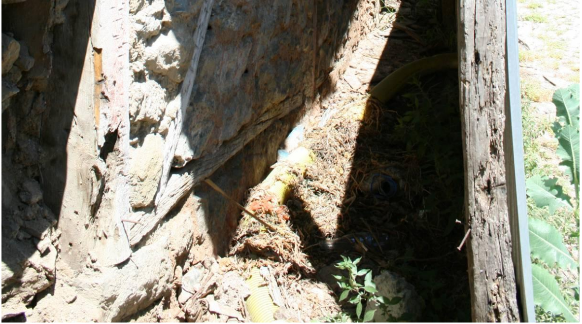
Fotoğraf 3.31 BB04 yapısında kagir bodrum duvarlarına oturan ahşap dikmeler
