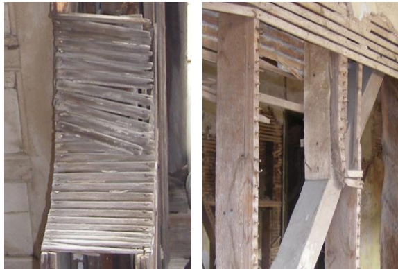
Fotoğraf 3.13 Bağdadi çıtaları ve bezeme elemanlarında kullanılan boyutta çivi örnekleri
