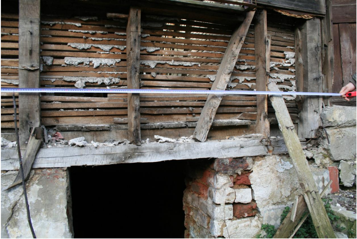
Fotoğraf 3.6 BB44 yapısı (yıkılmadan önce) kâgir duvar ahşap duvar birleşimi
