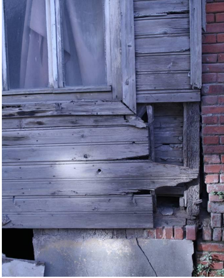
Fotoğraf 3.17 BB16 yapısının köşesinde yer alan taban ve dikmenin ilişkisi
