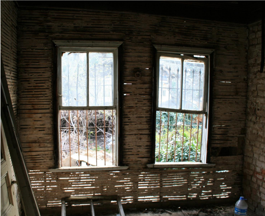
Fotoğraf 3.9 BB44 yapısında (yıkılmadan önce) bağdadilerin dizisi
