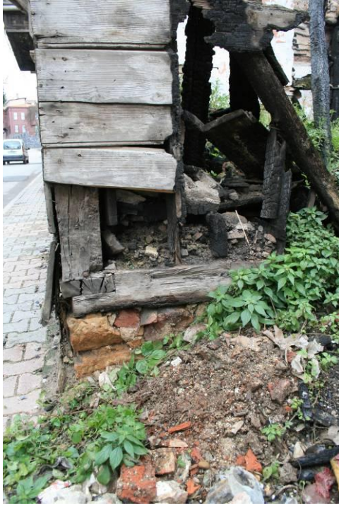
Fotoğraf 3.19 BB46 yanmış olan yapının kalan kagir duvar üzerinde tabanların birleşimi
