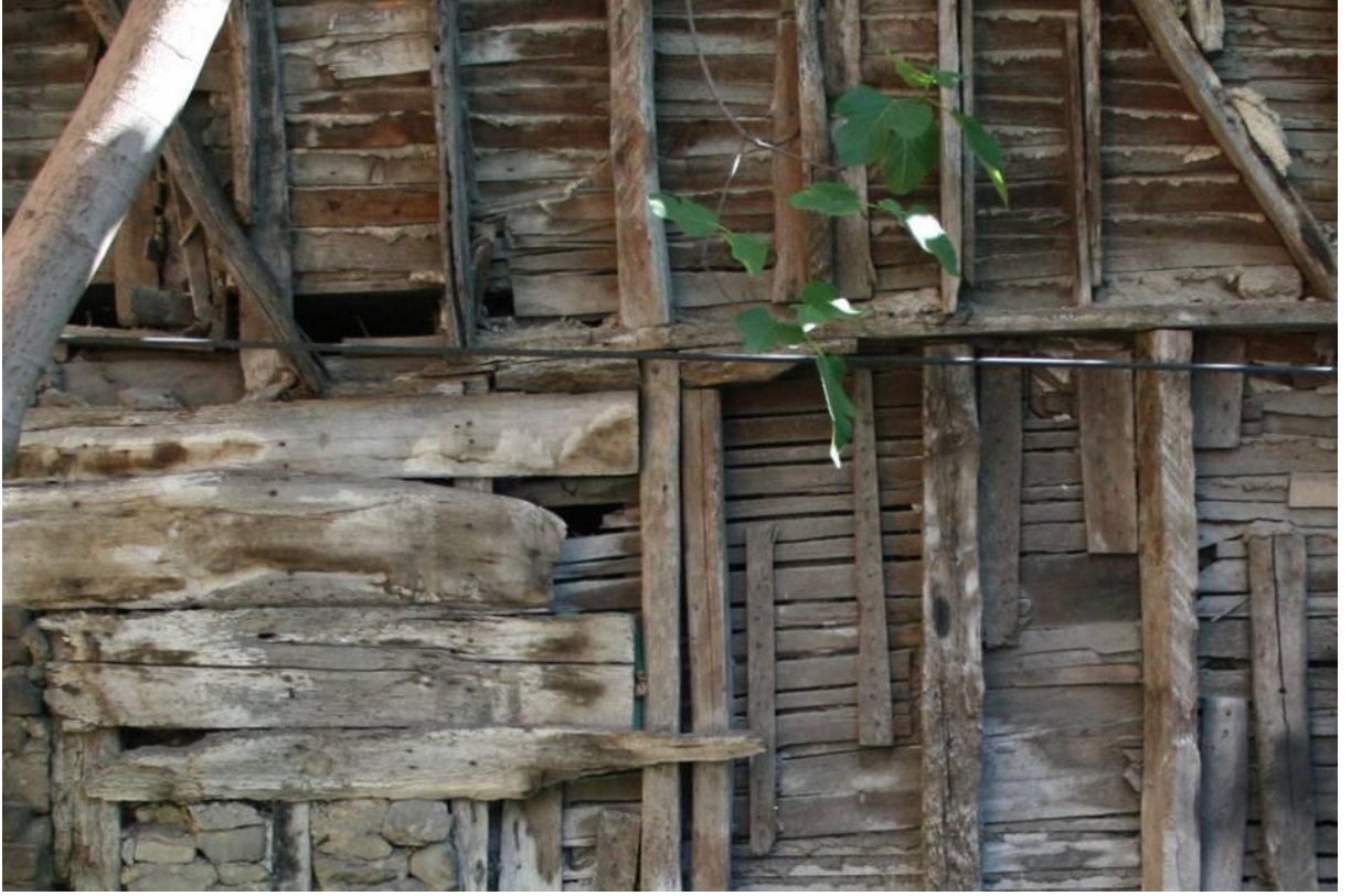
Fotoğraf 3.29 ÇK03 deformasyona uğramış duvar dokusunda başlık üzerinde ek yapılan birinci kat tabanı
