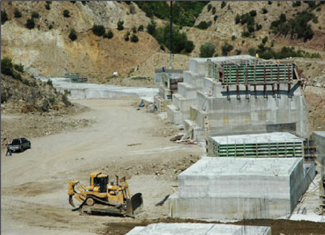
Şekil 13: Çaltıkoru Barajı ( http://www.dsi.gov.tr ).
