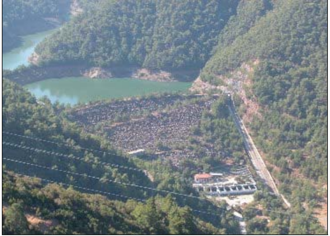
Şekil 6: Balçova Barajı ( http://www.dsi.gov.tr ).
