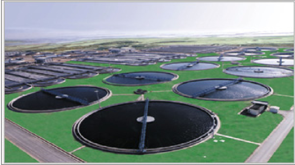
Şekil 4.13 İzmir Biyolojik Atıksu Arıtma tesisi (İZSU Genel Müdürlüğü, 2007).
