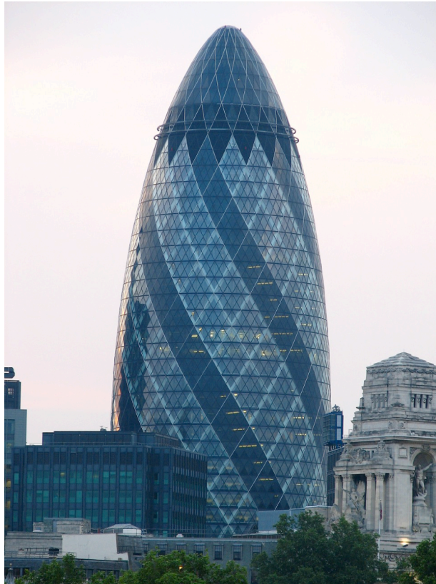
Şekil 28: Swiss Re Binası
